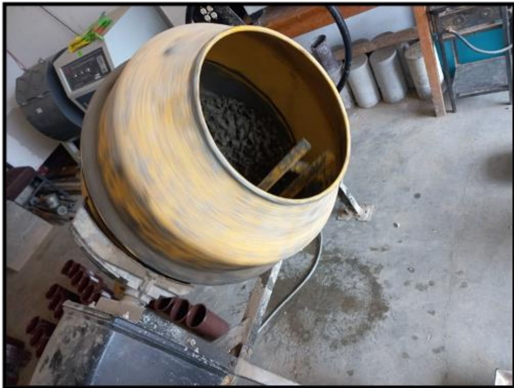
SE OBSERVA EL PROCESO DE MEZCLADO DE MATERIALES
