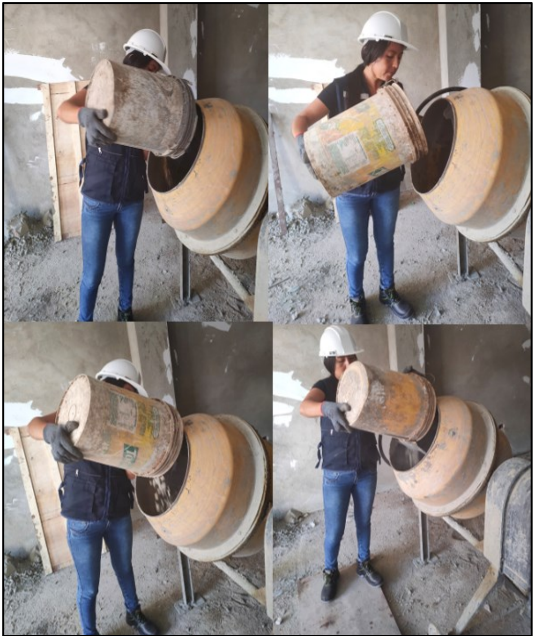
Figura 32 Elaboración del concreto para los adoquines tipo 1 (Patrón)
