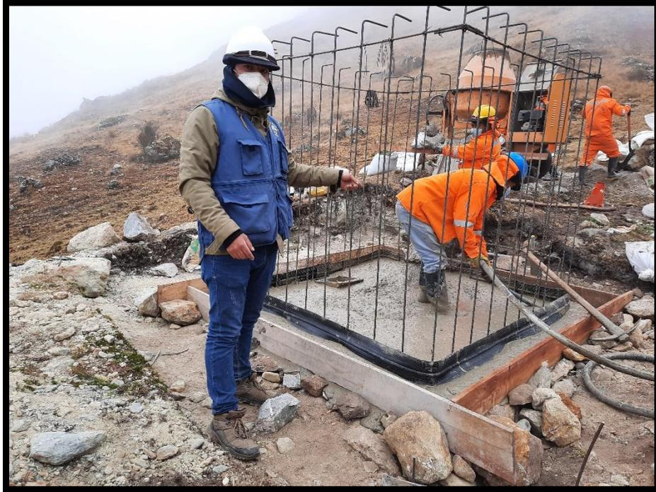
Vaciado de concreto  $f'c=280\text{kg/cm}^2$  para reservorio.
