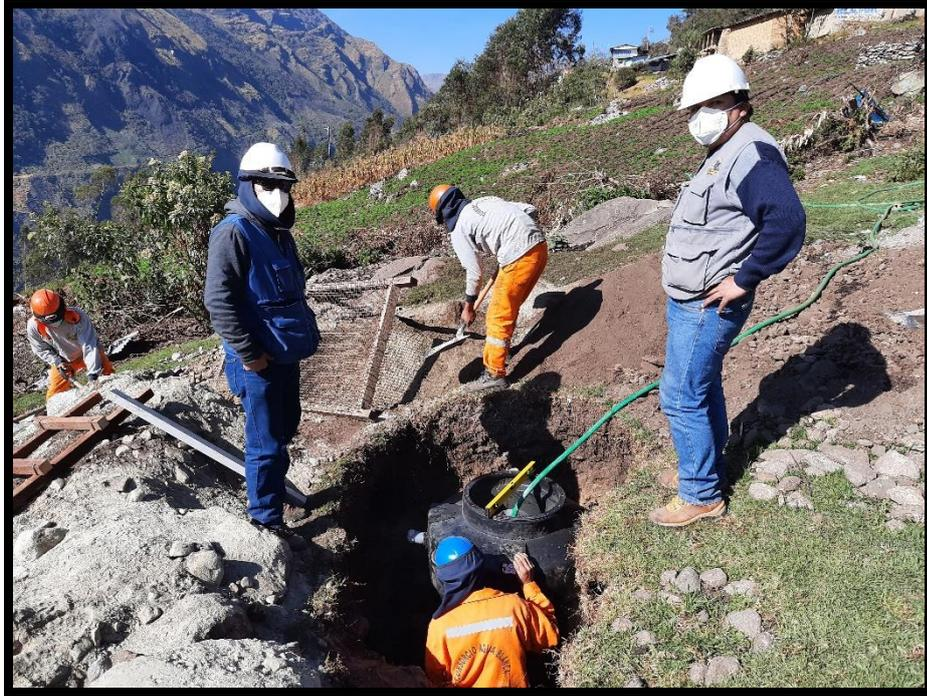
Instalación del biodigestor de 750 lts.
