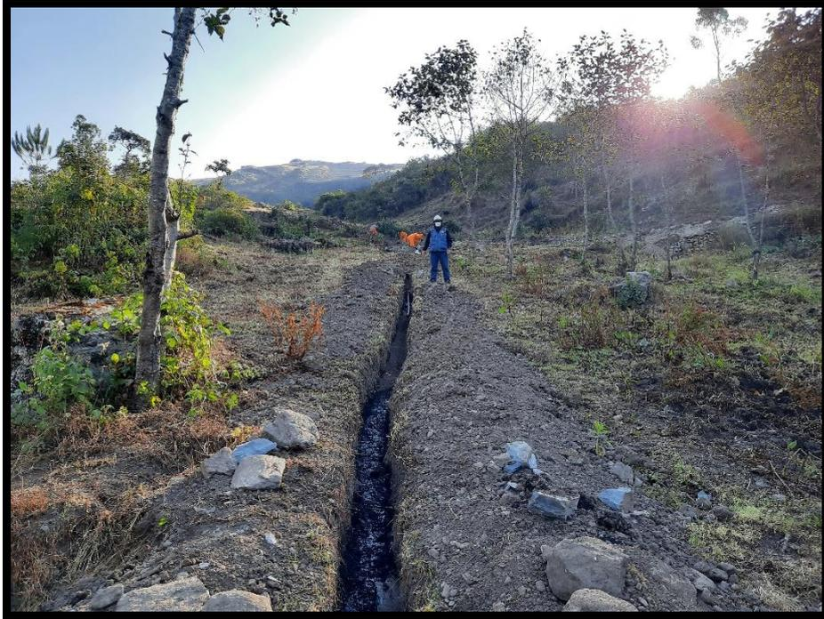
Tendido de tubería 3/4" para la red de distribución.
