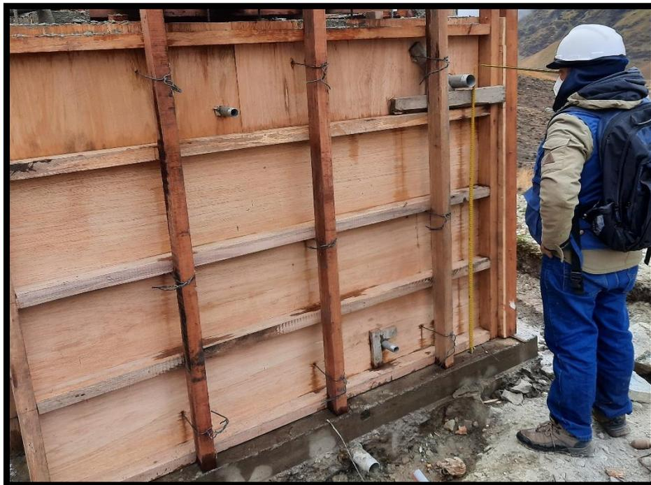
Verificación del encofrado para muros reforzados en reservorio.
