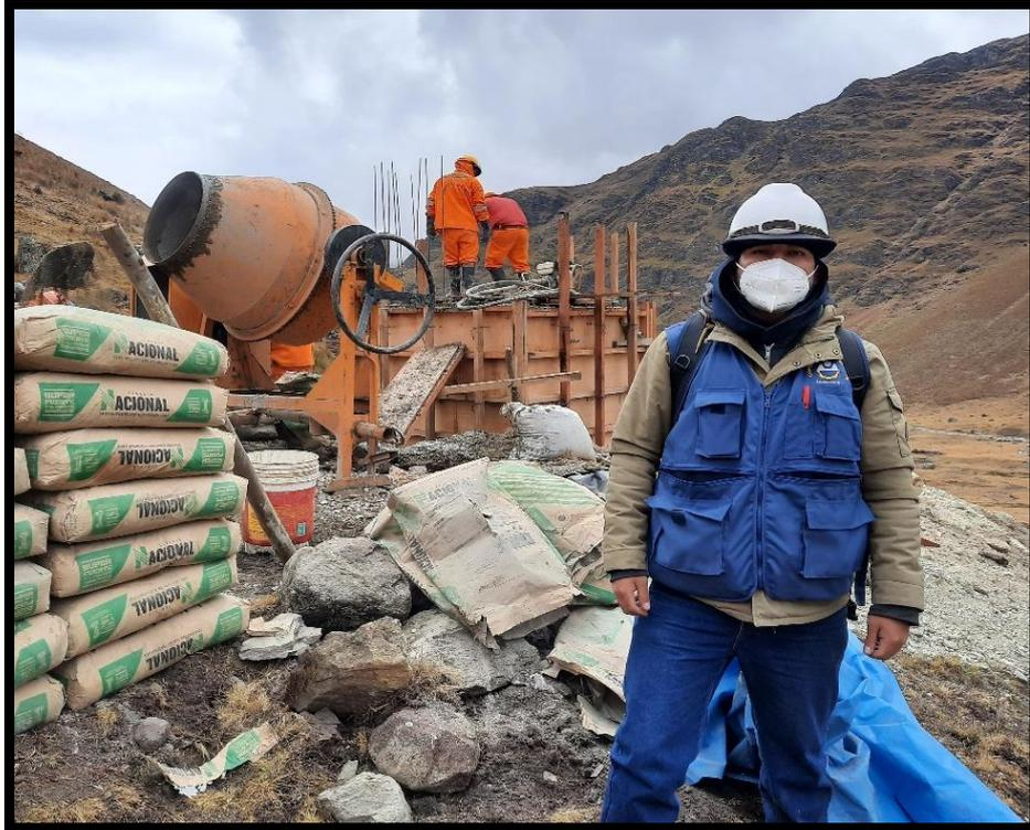
Vaciado de concreto  $f'c=280\text{kg/cm}^2$  para muros reforzados en reservorio.
