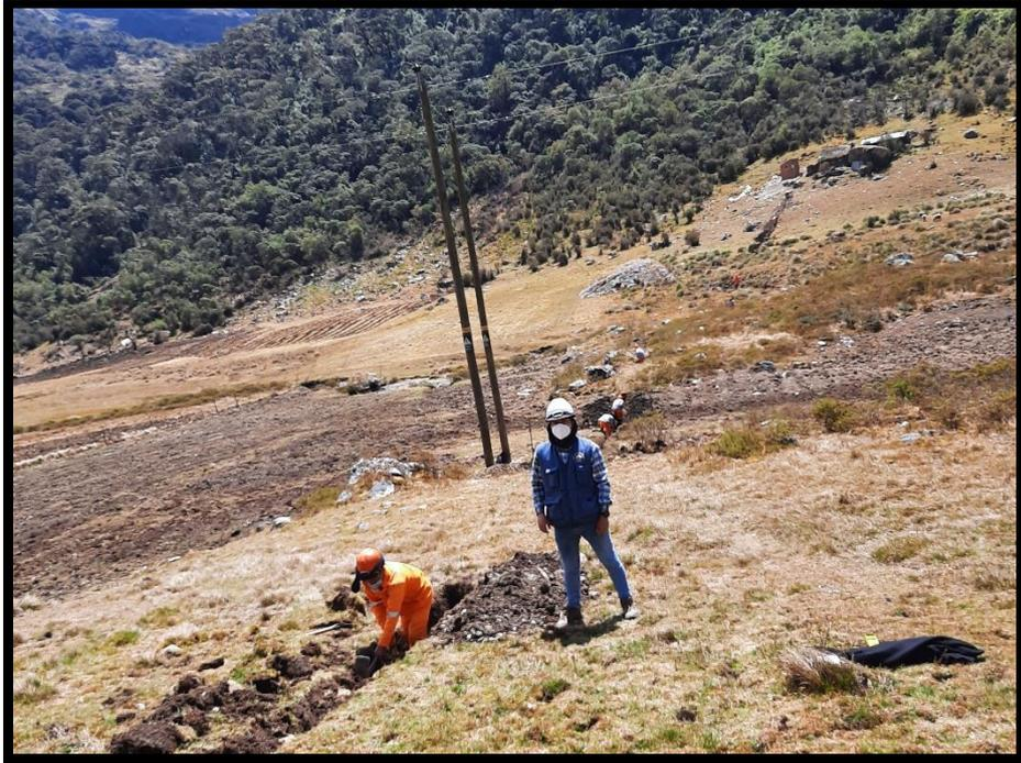
Excavación de zanja para la red de distribución de 3/4"
