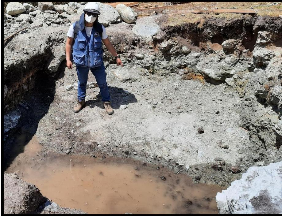
Trazo, replanteo y excavación para la captación de agua.
