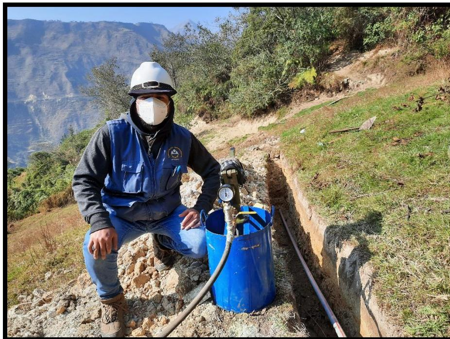
Verificación de la prueba hidráulica para la red de distribución de tubería 3/4".
