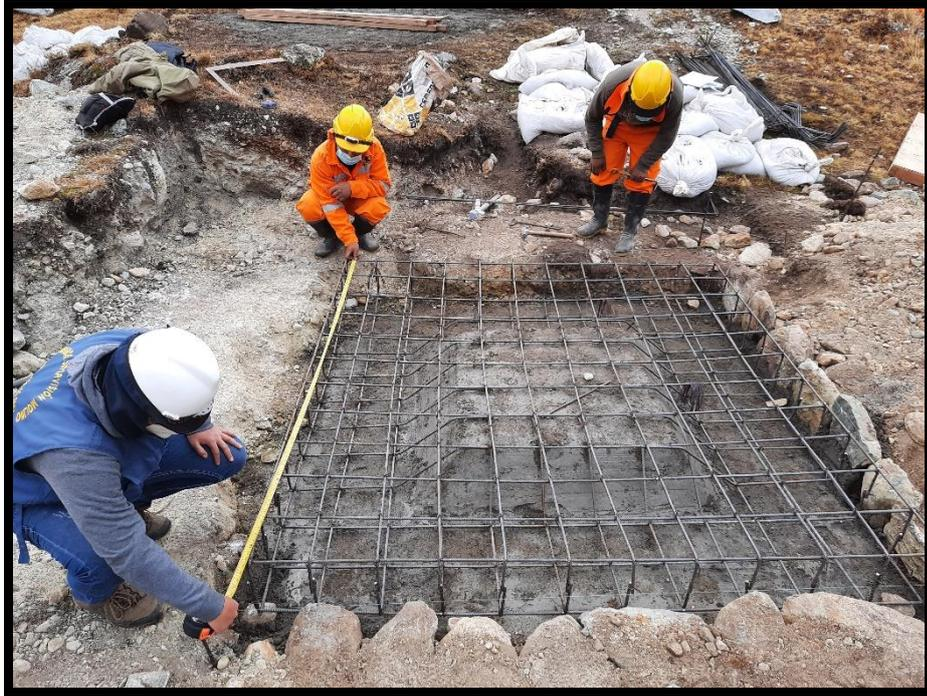
Verificación del acero  $f_y=4200\text{kg/cm}^2$  para reservorio.
