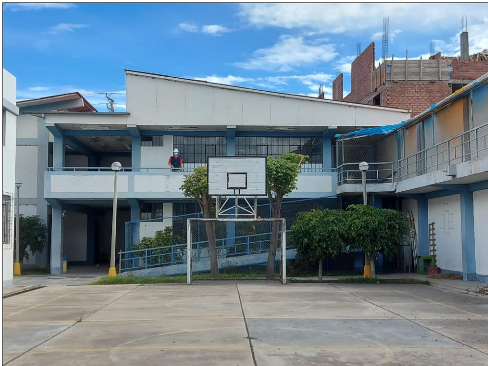
Vista fotográfica de la fachada del módulo I.
