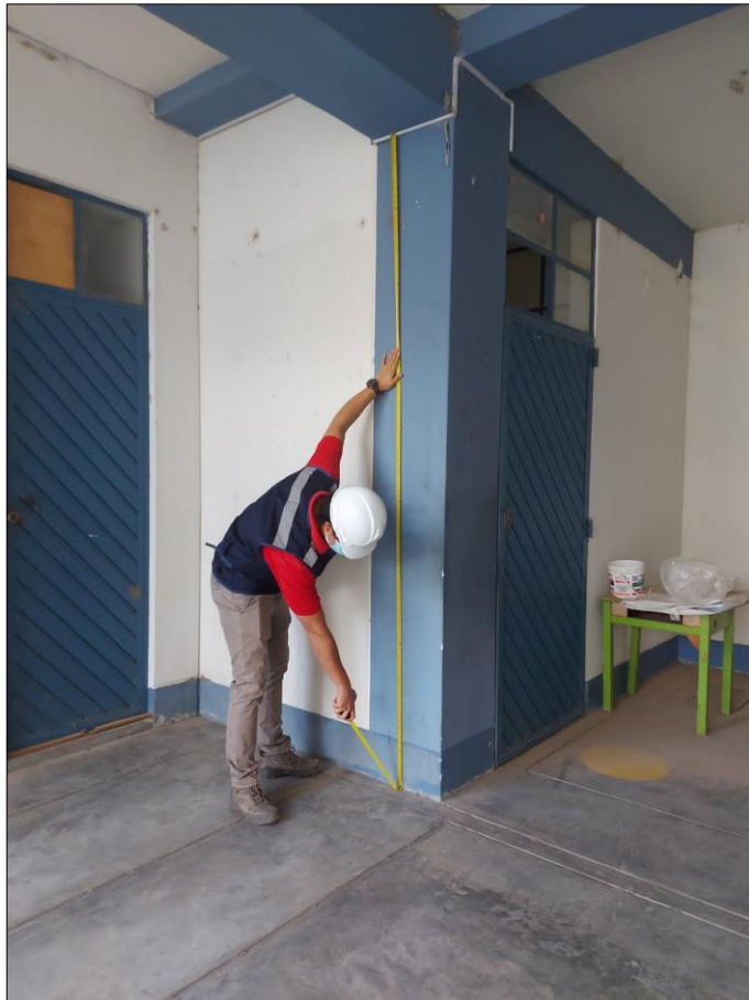
Vista fotográfica de la corroboración de medidas en el módulo I.
