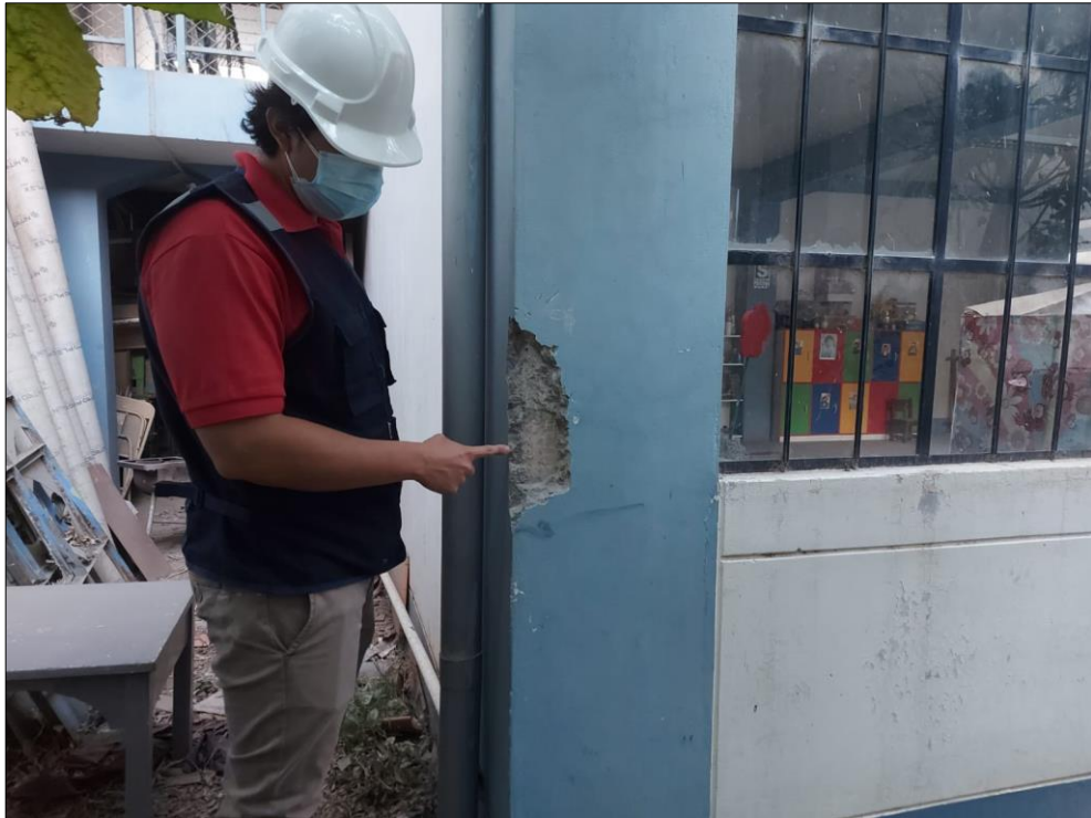
Vista fotográfica de zona seleccionada para el ensayo de esclerometría en el módulo I.
