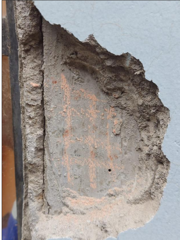
Vista fotográfica de zona seleccionada para el ensayo de esclerometría en el módulo I.
