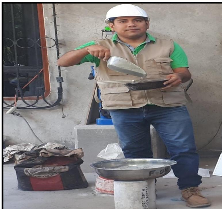
Iniciamos el procedimiento del mezclado entre yeso y cemento, para obtener una superficie uniforme en los bloques de concreto (ladrillos).
