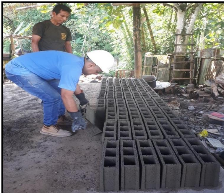
Se continua con el proceso del desmolde del desmolde metálico de los bloques de concreto (ladrillos), hasta obtener una población total de 80 unidades.
