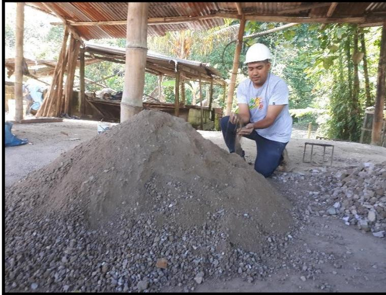
Realizamos un análisis del agregado para realizar el proceso de mezclado, luego del proceso tamizaje por la malla N°4.
