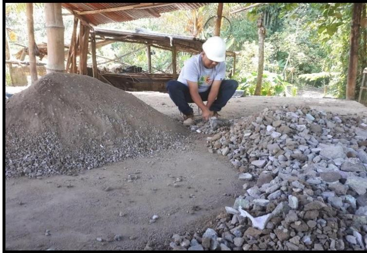
Se continua con el proceso manual de trituración de los residuos producto de la demolición de obras civiles para obtener el material adecuado para realizar la mezcla.
