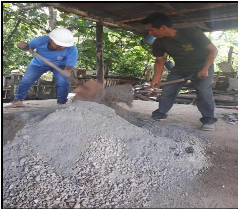
Se inicia el proceso de mezclado manual entre el agregado y el cemento, con la asistencia de un peón.
