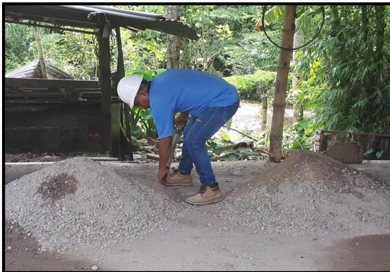
Se inicia el proceso de mezclado del agregado obtenidos del proceso tamizaje por la malla N°4.
