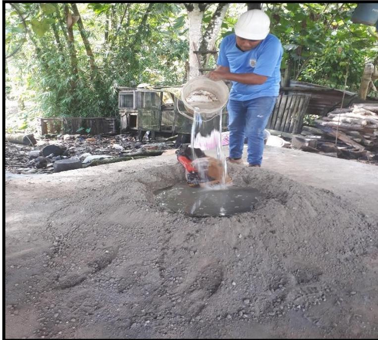
Se realiza el cálculo de agregado (agua potable) para realizar la mezcla echo con residuos producto de la demolición y construcción de las obras civiles.
