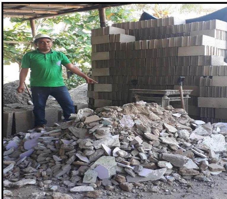
Se inicia el proceso manual de trituración de los residuos producto de la demolición de obras civiles.
