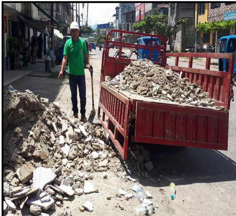
Proceso de descarga de los residuos producto de la demolición de obras civiles en el lugar de almacenamiento.
