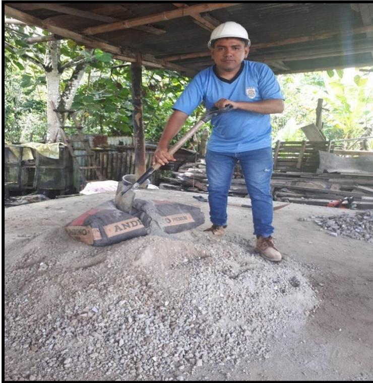
Mezclado del agregado y el cemento.
