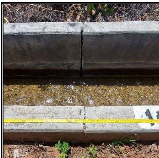
Nota: Se verifica el correcto uso de la junta en el canal riego Canchan Lindero – Tomaykichwa, Provincia de Ambo.
