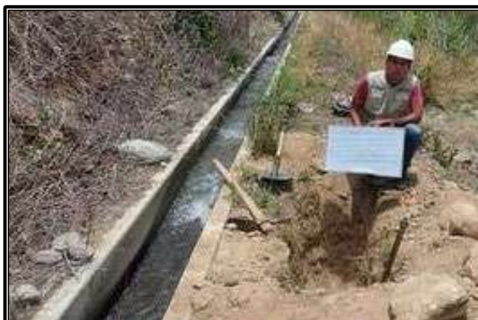
Nota: Calicata 2 canal Canchan Lindero – Tomaykichwa, Provincia de Ambo.
