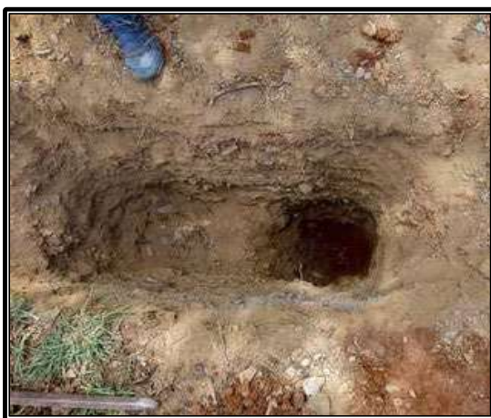
Nota: Calicata 1 canal Canchan Lindero – Tomaykichwa, Provincia de Ambo.
