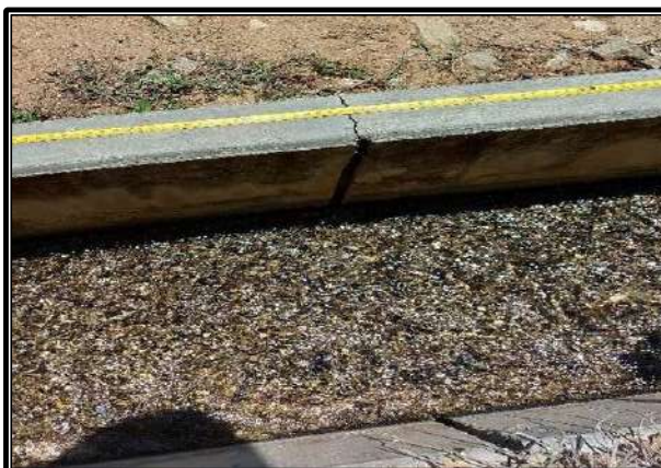
Nota: Se verifica el correcto uso de la junta en el canal riego Canchan Lindero – Tomaykichwa, Provincia de Ambo.
