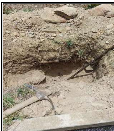
Nota: Toma de muestra Calicata 2 canal Canchan Lindero – Tomaykichwa, Provincia de Ambo.
