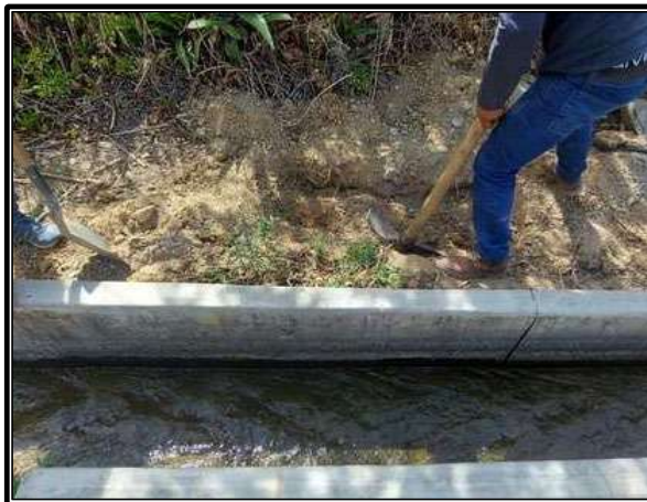
Nota: Inicio de la excavación de la Calicata 1 canal Canchan Lindero – Tomaykichwa, Provincia de Ambo.
