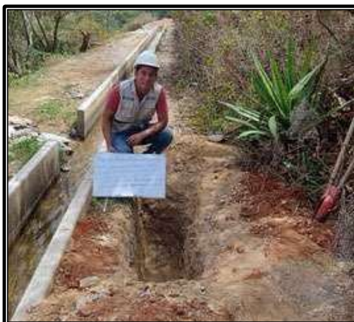
Nota: Calicata 1 canal Canchan Lindero – Tomaykichwa, Provincia de Ambo.
