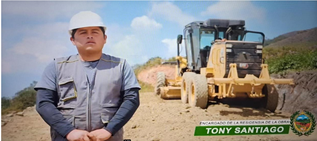
Figura 2 Residente de obra
