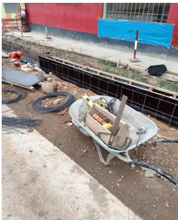
Evaluación de las Herramientas manuales principales para el uso en la construcción del pavimento rígido
