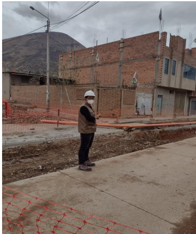
Vista del proceso constructivo del pavimento rígido
