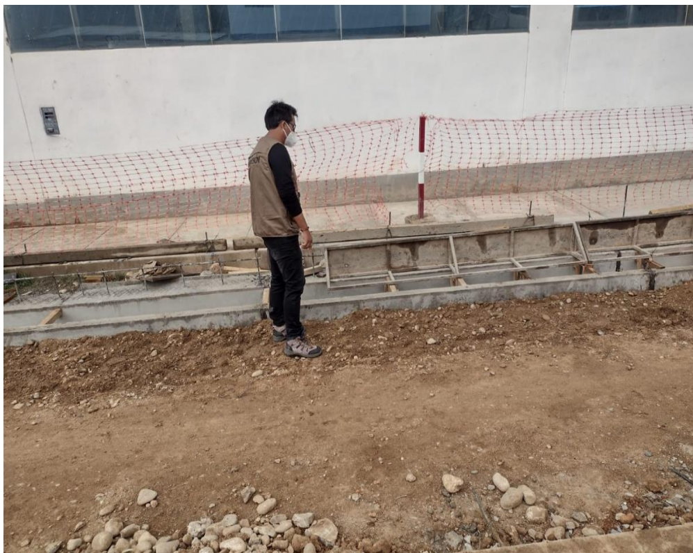
Vista del proceso constructivo de las cunetas del pavimento rígido
