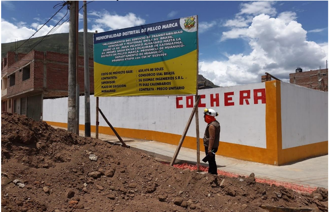
Trabajos de movimiento de tierra
