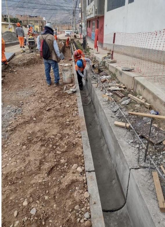
Vista del proceso constructivo de las cunetas componente del pavimento rígido
