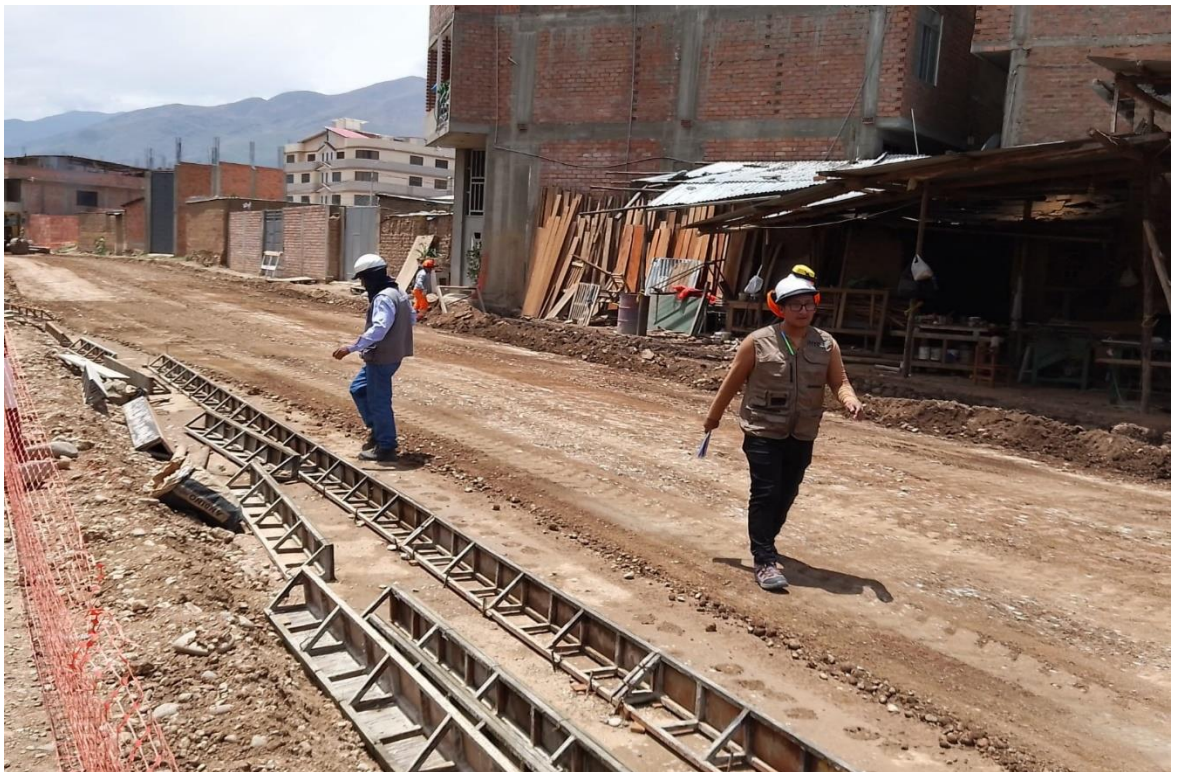
Toma de datos en los trabajos de nivelación, perfilado de terreno y encofrado
