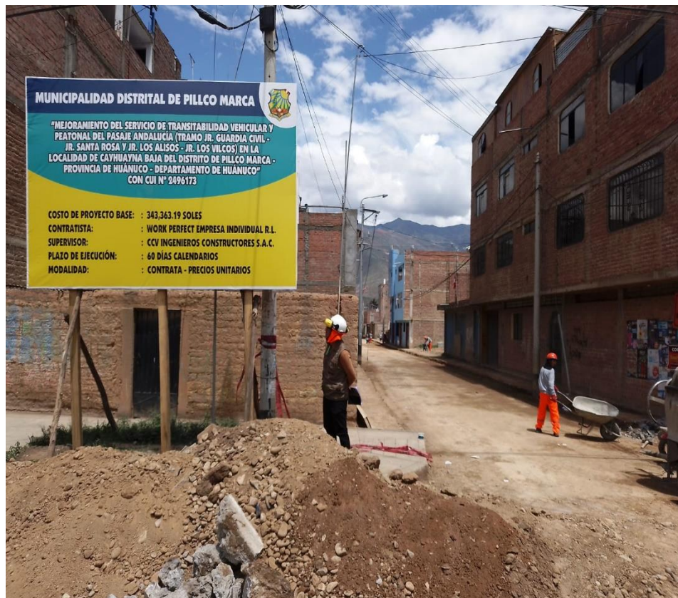
Vista del cartel de Obra
