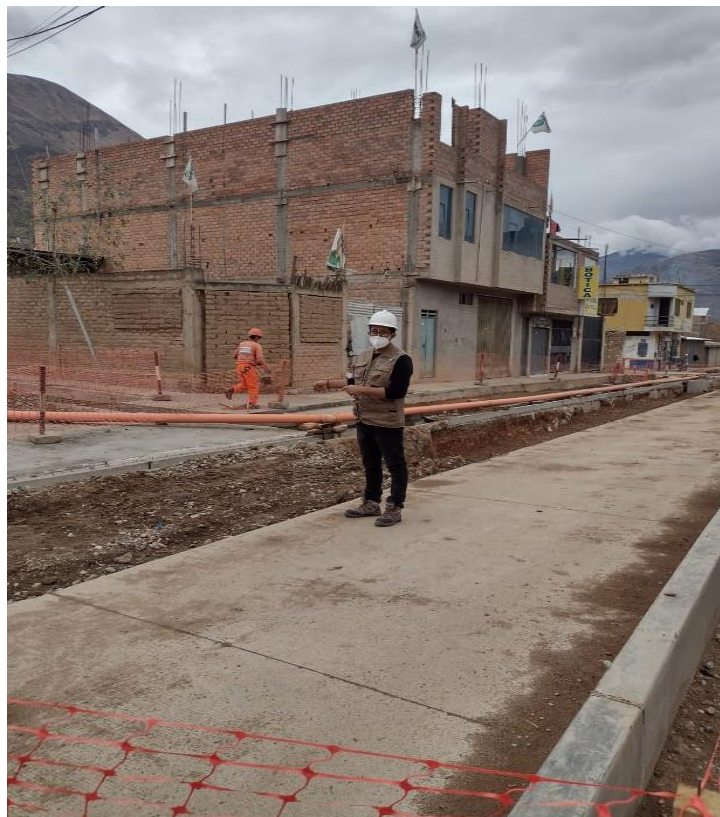
Vista General del proceso constructivo y estado del pavimento rígido
