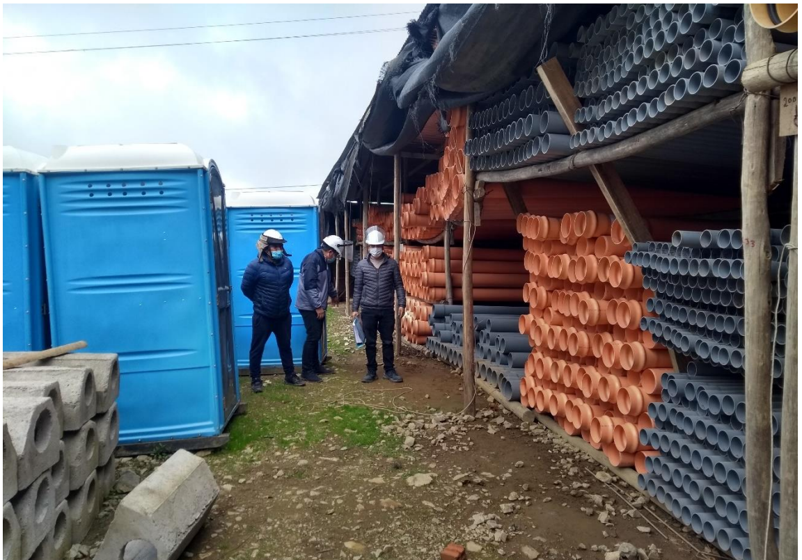
Otra vista fotográfica donde se observa la verificación por parte de la supervisión el abastecimiento de los materiales en obra
