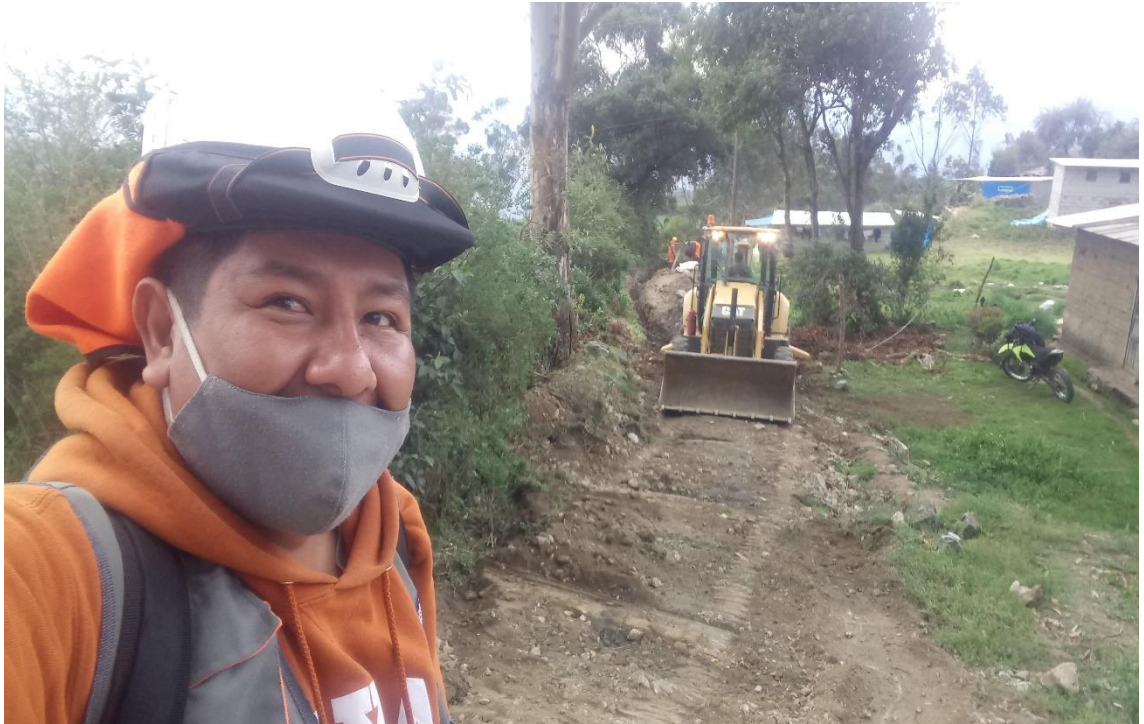
En la vista fotográfica se observa los trabajos de excavación con maquinaria en unos de los frentes de trabajo, para el suministro e instalación de tuberías PVC.
