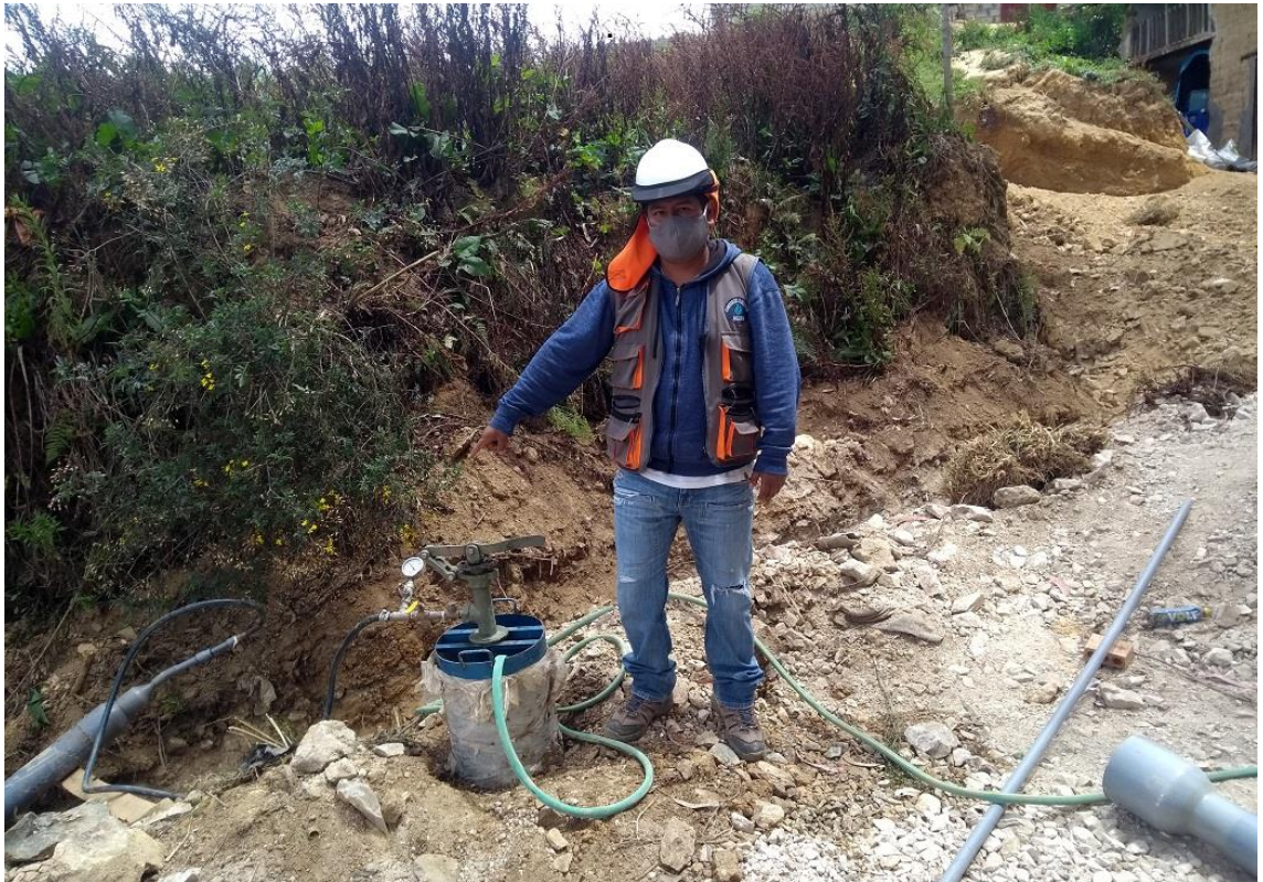
En la vista fotográfica se observa los trabajos de pruebas hidráulicas a la línea de conducción a zanja tapada.
