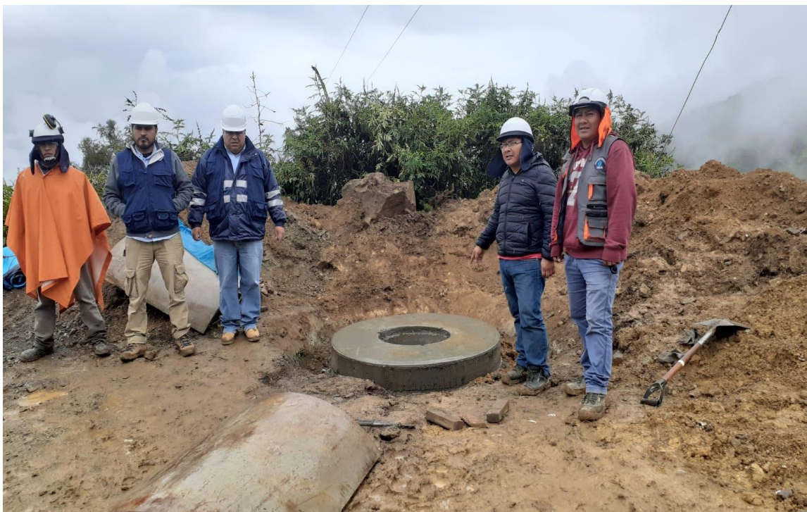
En la vista fotográfica se observa a la supervisión verificando los trabajos de concreto en la red colector como son los buzones de concreto armado.
