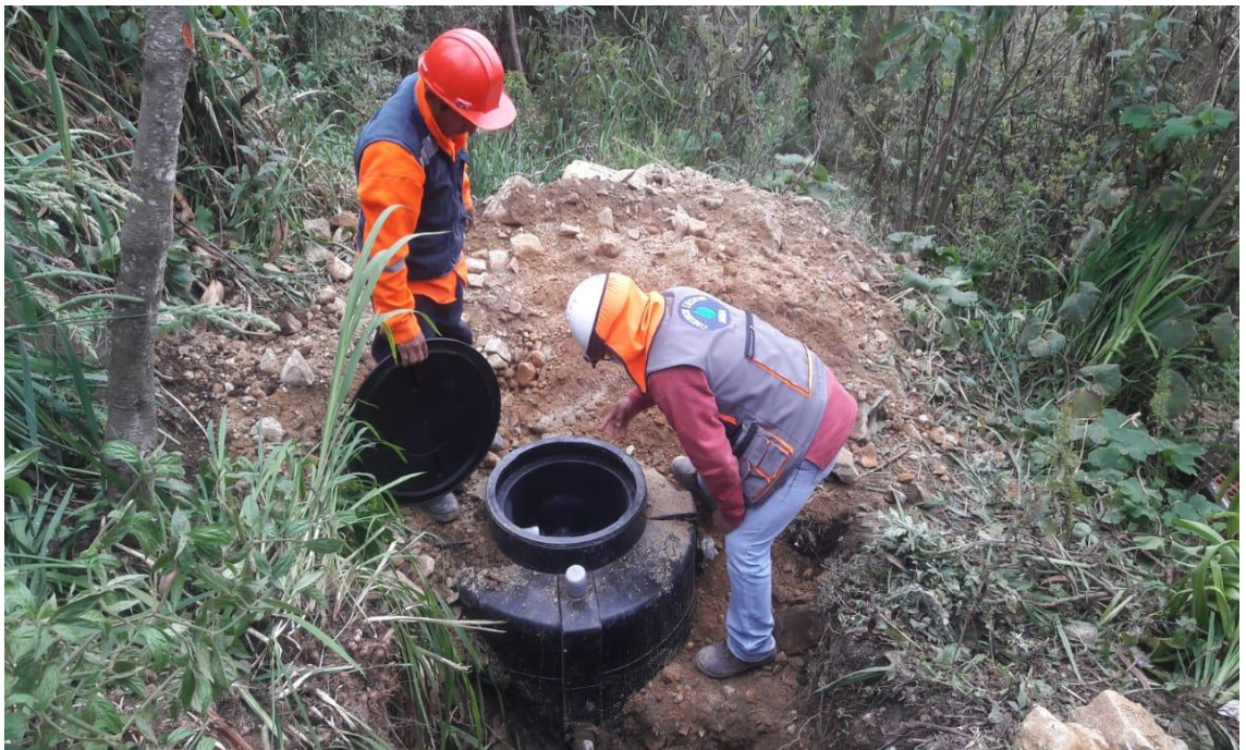
En la vista fotográfica se observa la instalación de la tecnología del sistema biodigestor en las viviendas beneficiarias.
