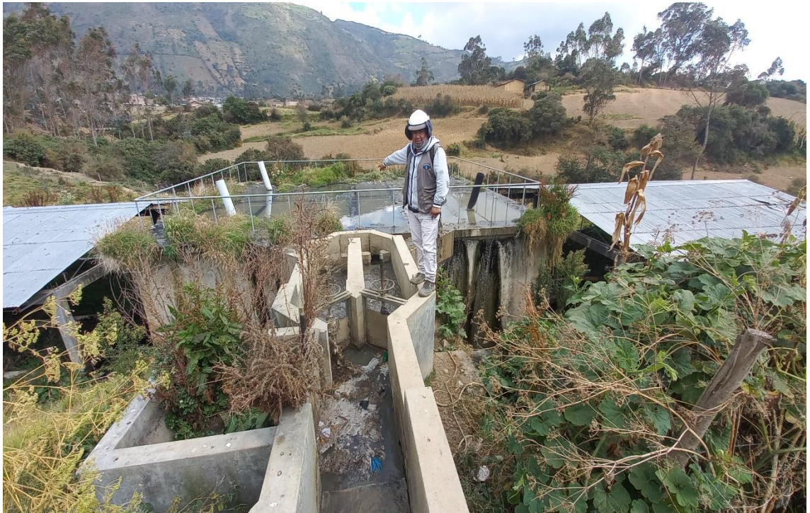
En la vista fotográfica se observa la verificación de las estructuras existentes para el mejoramiento del sistema de Agua Potable.
