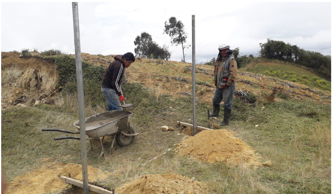
Otra vista fotográfica donde se observa la instalación del cerco perimétrico en el reservorio circular existente, siendo el trabajo de mejoramiento
