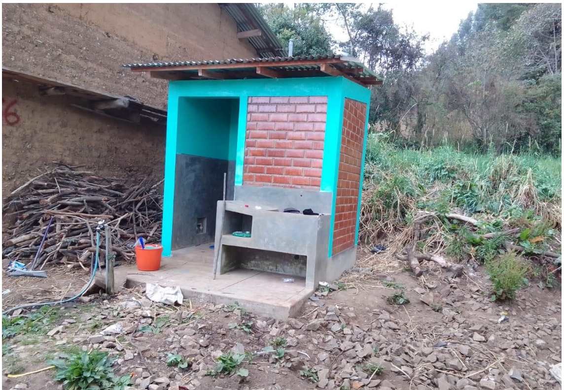
En la vista fotográfica se observa los trabajos concluidos en la instalación domiciliar de los UBS con arrastre hidráulico. En la población beneficiaria.
