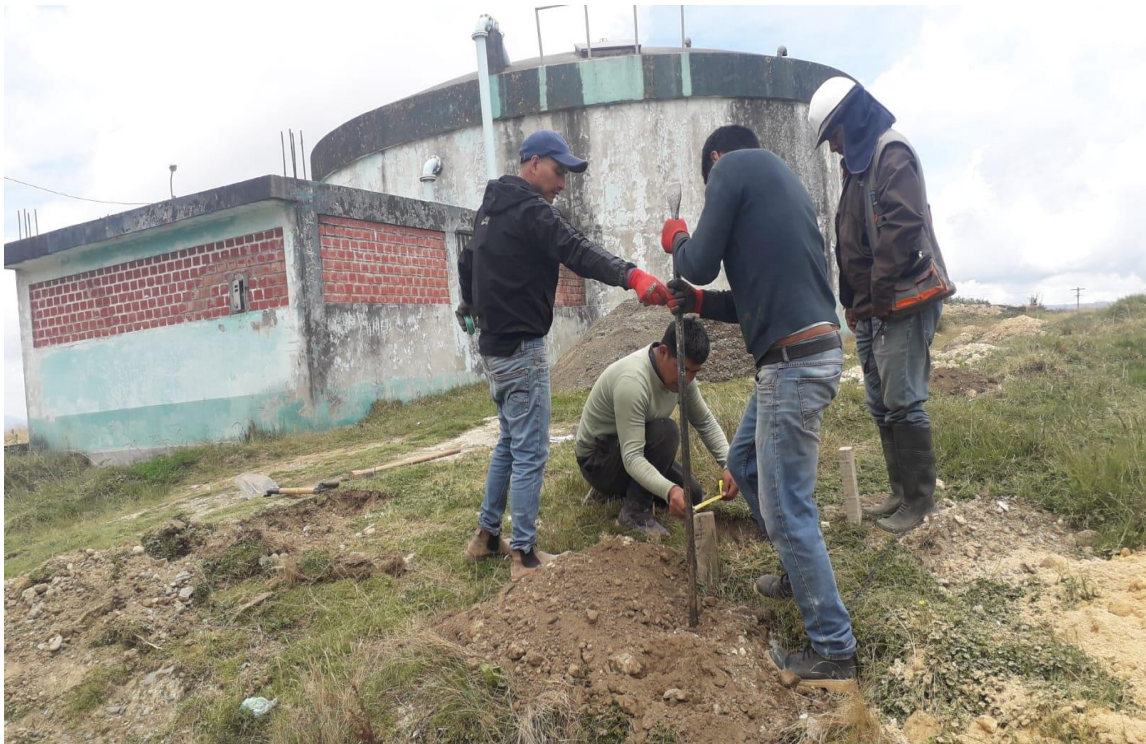
En la vista fotográfica se observa la instalación del cerco perimétrico en el reservorio circular existente, siendo el trabajo de mejoramiento.
