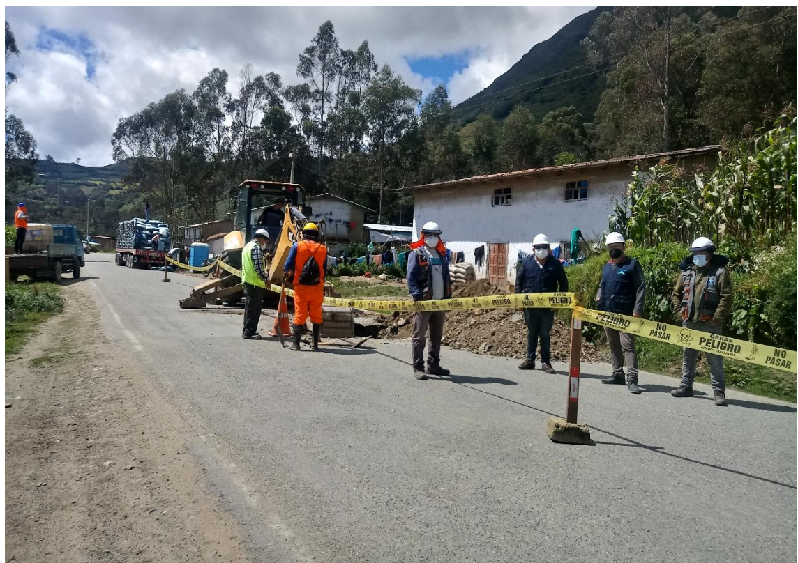
En la vista fotográfica se observa a la Supervisión verificando los trabajos en la línea de conducción del Agua Potable
