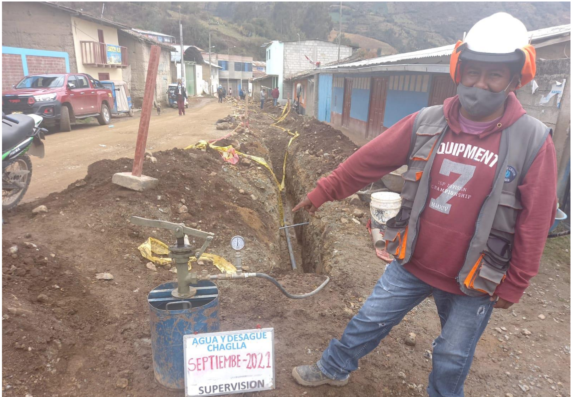
En la vista fotográfica se observa los trabajos de la prueba hidráulica para la verificación de la tubería en la red de distribución.
