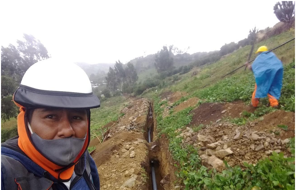
En la vista fotográfica se observa el suministro e instalación de la Tubería PVC SAP para la línea de conducción del sistema de agua potable
