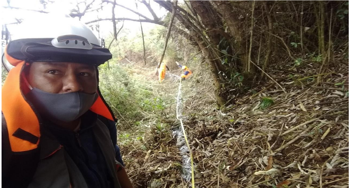
En la vista fotográfica se observa la verificación del Trazo y Replanteo en la línea de conducción del proyecto
