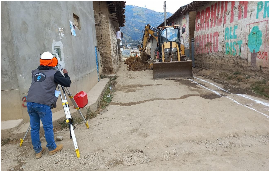
En la vista fotográfica se observa los trabajos de replanteo para la red de distribución con equipo topográfico, además de la maquinaria utilizada.
