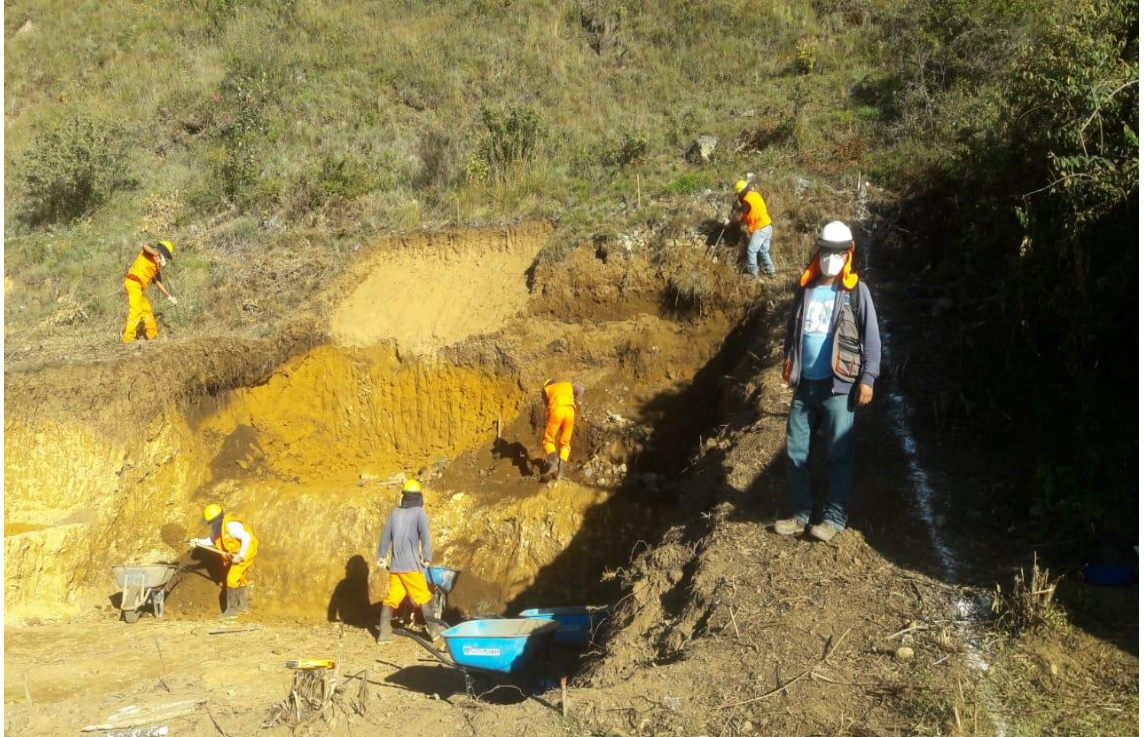
En la vista fotográfica se observa los trabajos de excavación y corte en talud, para conformar la plataforma para la instalación del reservorio cerrado de concreto armado.
