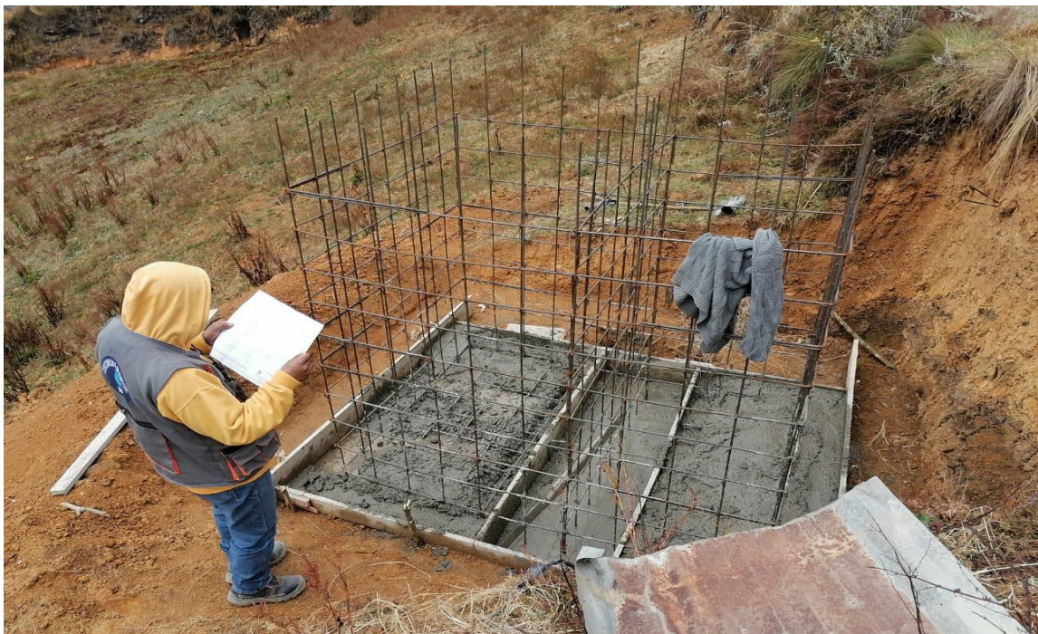
En la vista fotográfica se observa los trabajos de acero y concreto para la construcción del reservorio cerrado apoyado.
