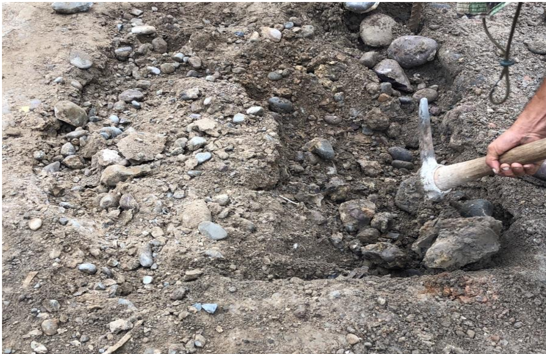
Excavación de la calicata N° 01 al Km 0+110 m.
