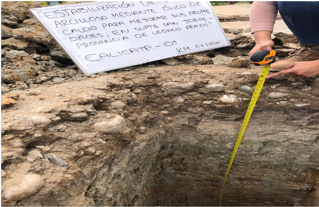
Excavación de la calicata N° 01 a una profundidad de 1.50 m.
