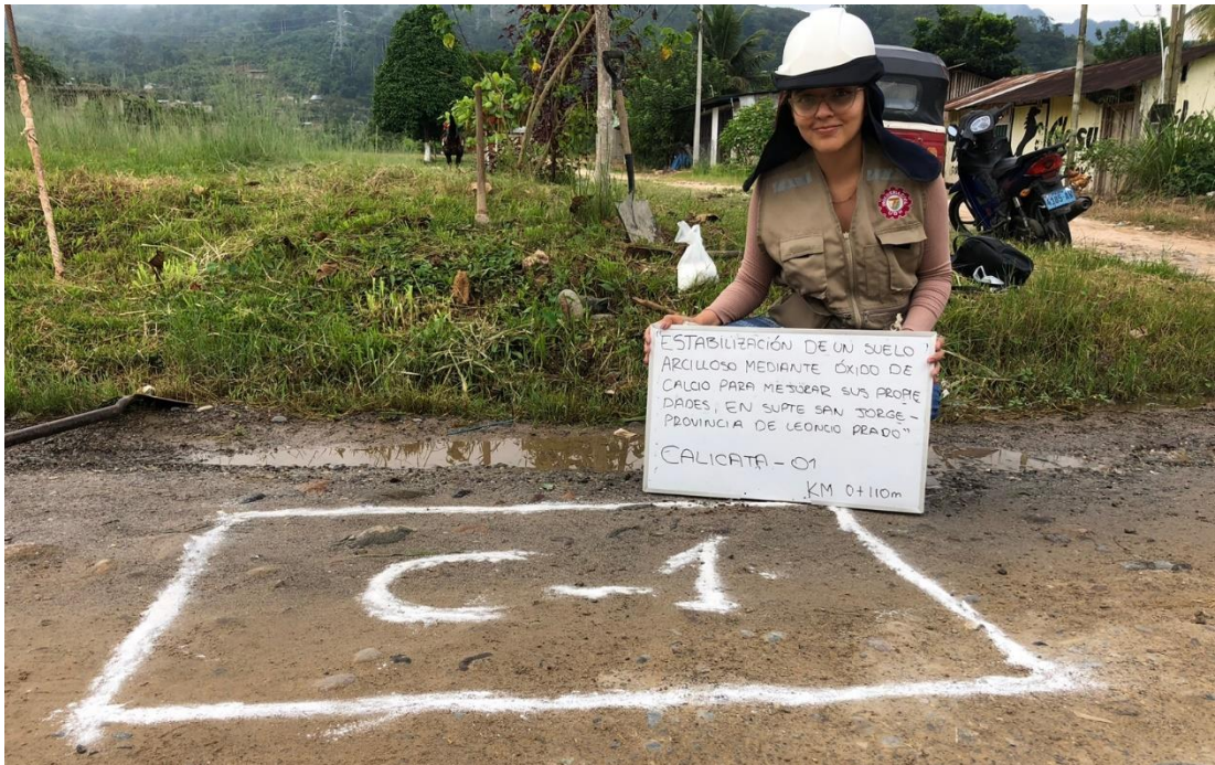
Señalización de la calicata N° 01.
