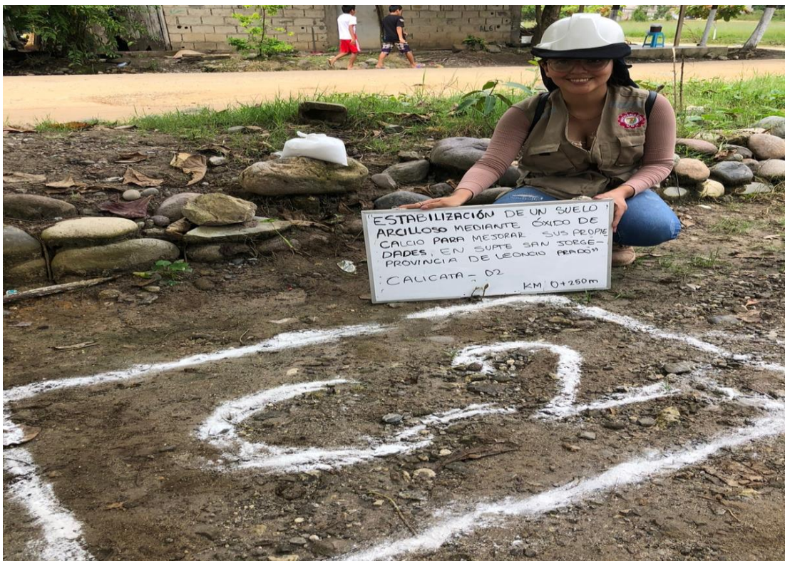
Señalización de la calicata N° 02 al Km 0+250 m
