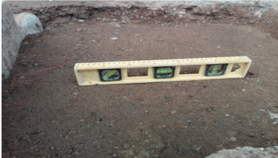
Nivelación de capas tras ser compactado.
