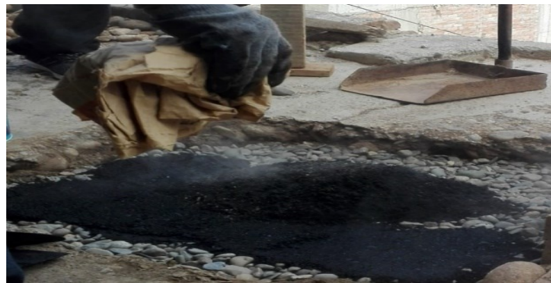
Vaciado de la mezcla asfáltica en el prototipo.
