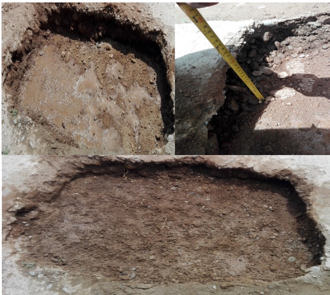
Excavación y acondicionamiento del suelo como subrasante para ambos prototipos.
