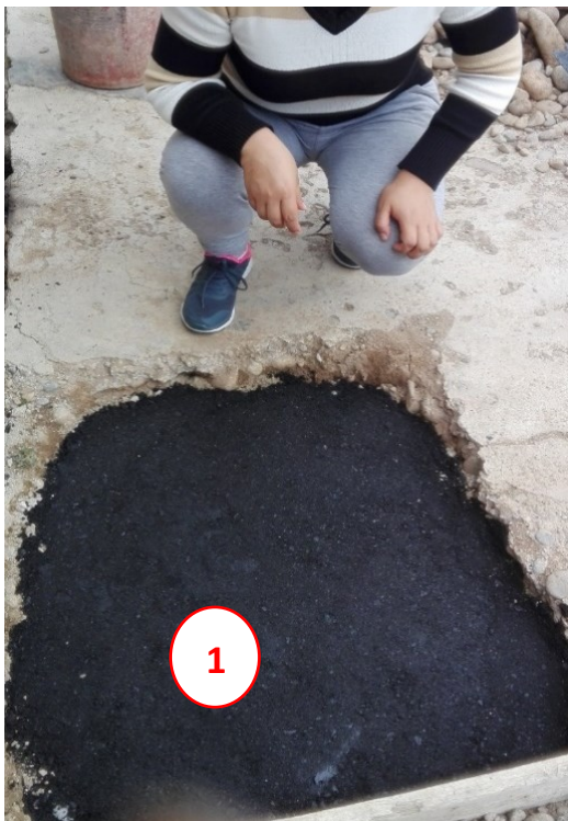
Llenado de carpeta asfáltica hasta espesor de 5 cm.
