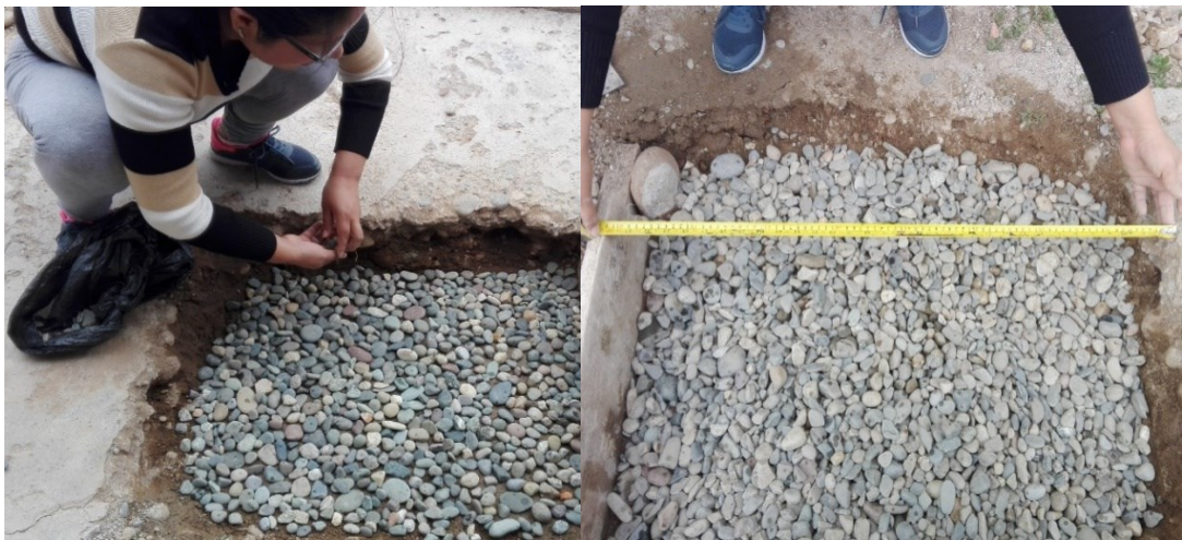
Colocación de piedras de canto rodado, cuyo tamaño oscila de 1" a 1 1 / 2 ".
