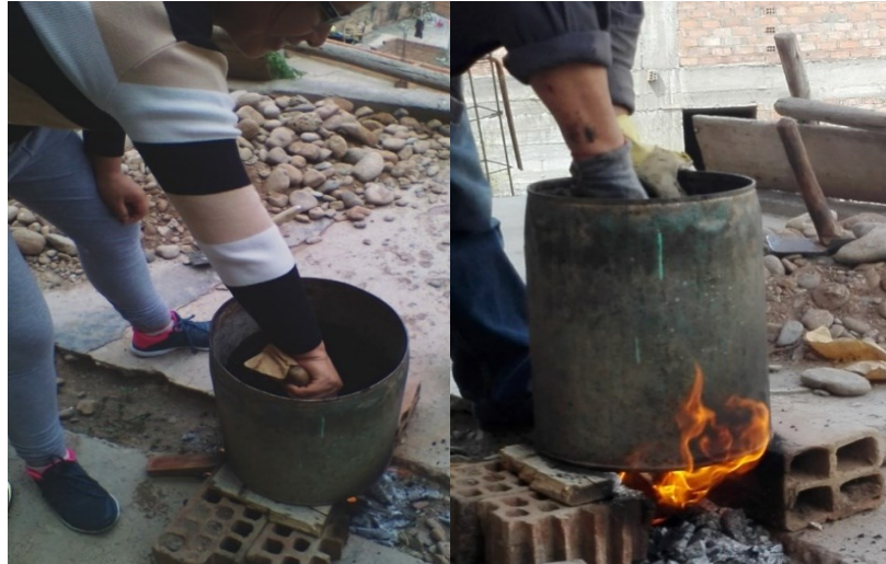
Homogenizando la mezcla asfáltica.
