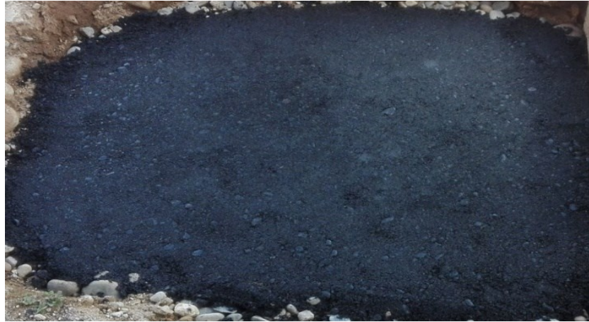
Llenado de carpeta asfáltica hasta espesor de 5 cm.
