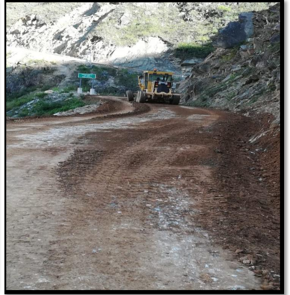
Se tiene la colocación de afirmado en el tramo I, Marayzondor, y la limpieza de talud.
