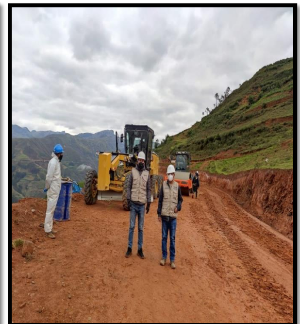
Se tiene el talud el cual se realizará el corte en roca fracturado, y se tiene el corte en terreno natural con maquinaria en tierra suelta
