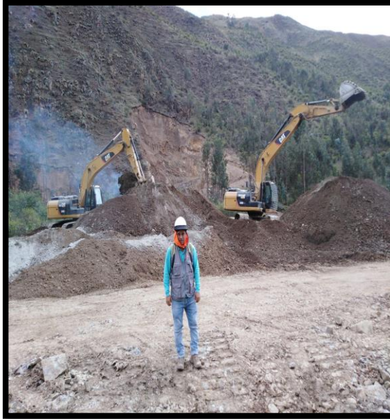
Se tiene la preparación del material afirmado en la carta el cual se utilizó en el afirmado de la vía.
