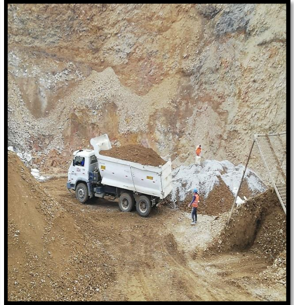
Se tiene la preparación del material afirmado en la carta el cual se utilizó en el afirmado de la vía.
