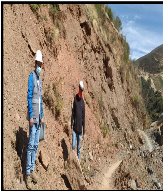
Se tiene el talud el cual se realizará el corte en roca fracturado, y se tiene el corte en terreno natural con maquinaria en tierra suelta
