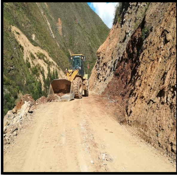
Se tiene la colocación de afirmado en el tramo I, Marayzondor, y la limpieza de talud.
