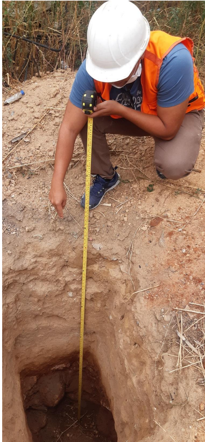
Figura 116 Calicata 01- Profundidad 3.00 m
