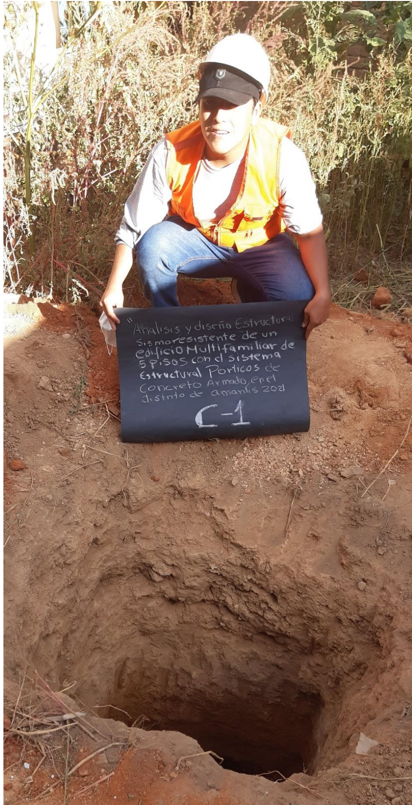
Figura 114 Estudio de Mecánica de Suelos – Calicata 01
