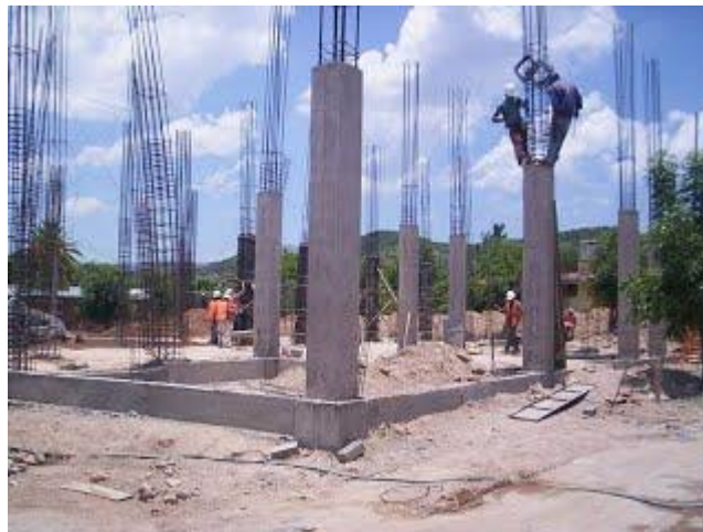
Figura 7 Columnas para sistema aporticado
