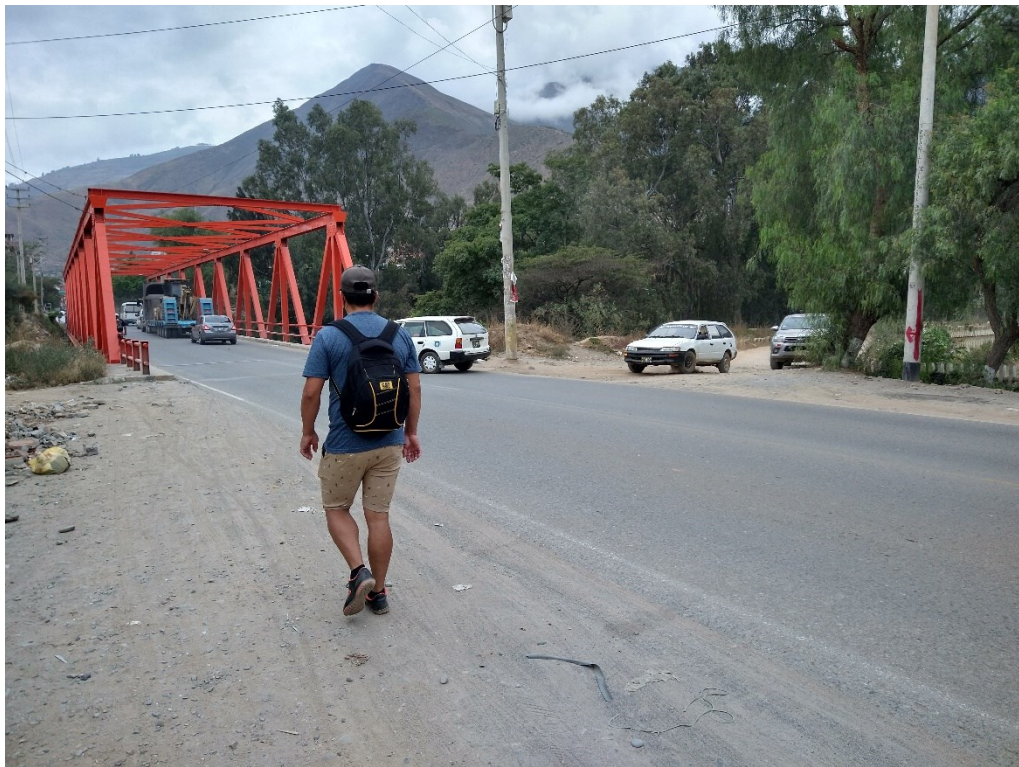
Fotografía 1. Falta de Señalizaciones y Dispositivos de Control de Tránsito. PillcoMarca
