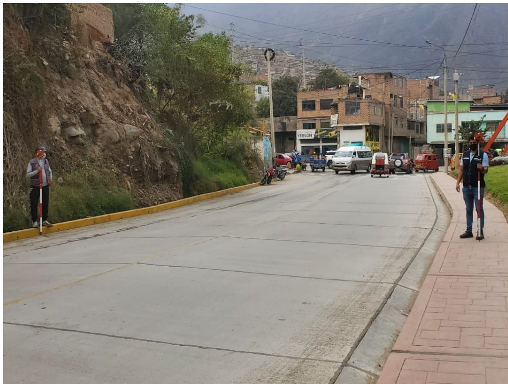
Trabajos de Levantamiento Topográfico en la zona en Estudio.
