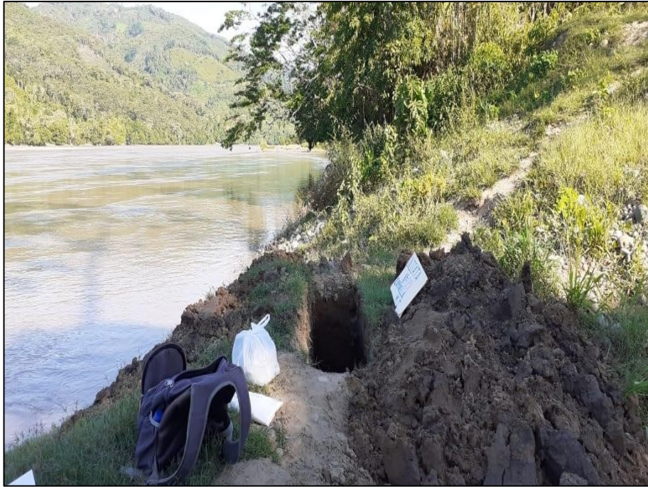
Foto : Se observa calicata excavada N° 01 (Progresiva: 0+640 - UTM WGS 84 / Zona 18S: E: 376673 - N: 9047588)
