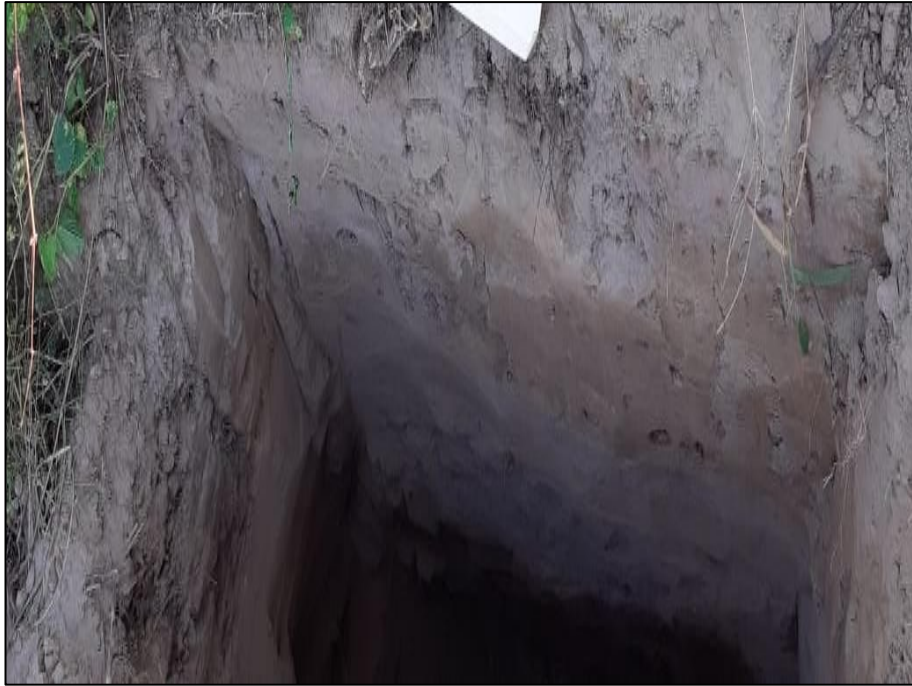
Foto : Se observa calicata excavada N° 03 (Progresiva: 0+040 - UTM WGS 84 / Zona 18S: E: 376129– N: 9048115) - Perfil del Suelo
