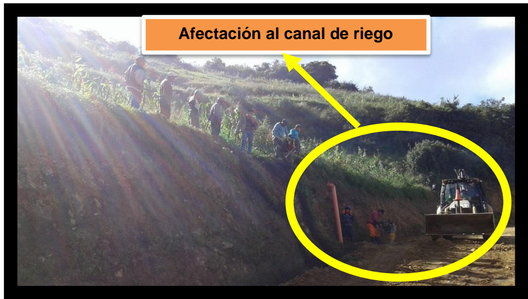
Imagen N°018. Contaminación acústica cerca de una Institución educativa. En la imagen se observa la puesta de tubo para remediar la clausura del canal de riego tushna que fue afectado por los cortes de talud.
