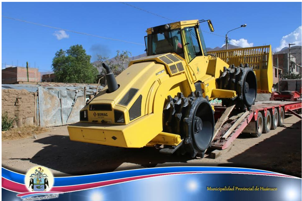
Compactadora que realiza el trabajo en el botadero controlado de Chilipampa. (Fuente Municipalidad de Huánuco)
