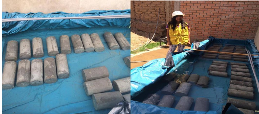
Gráfico 3.24 Realización del curado de probetas de concreto.
