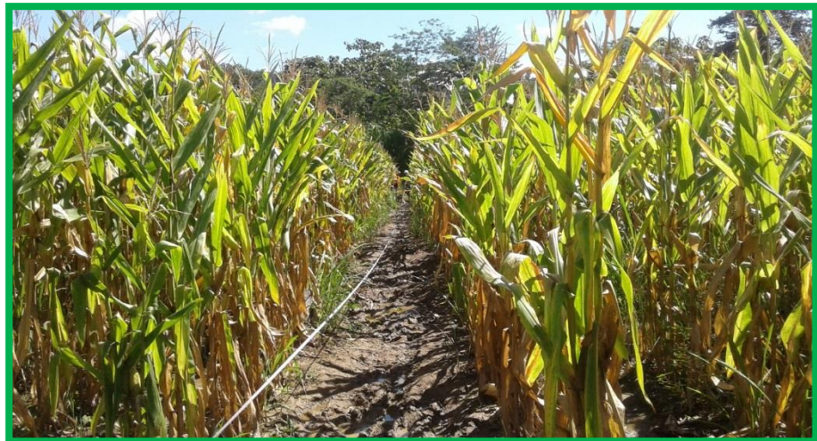
FOTO N°02: Se realiza la medición con wincha para la colocación de las estacas por progresivas.
