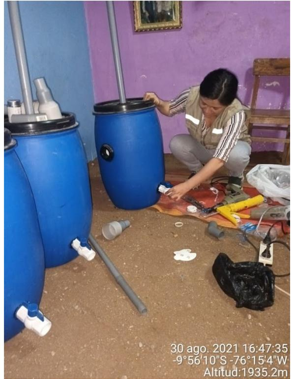
IMAGEN 11 y 12 PEGANDO CON EL USO DE SILICONA LOS ACCESORIOS CORRESPONDIENTES
