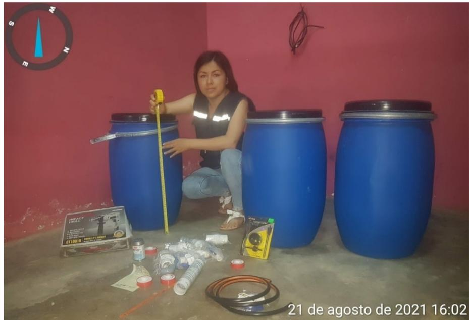
IMAGEN 01: INICIO DE ARMADO DE LOS BIODIGESTORES, MIDIENDO LA ALTURA CONVENIENTE PARA LAS PERFORACIONES
