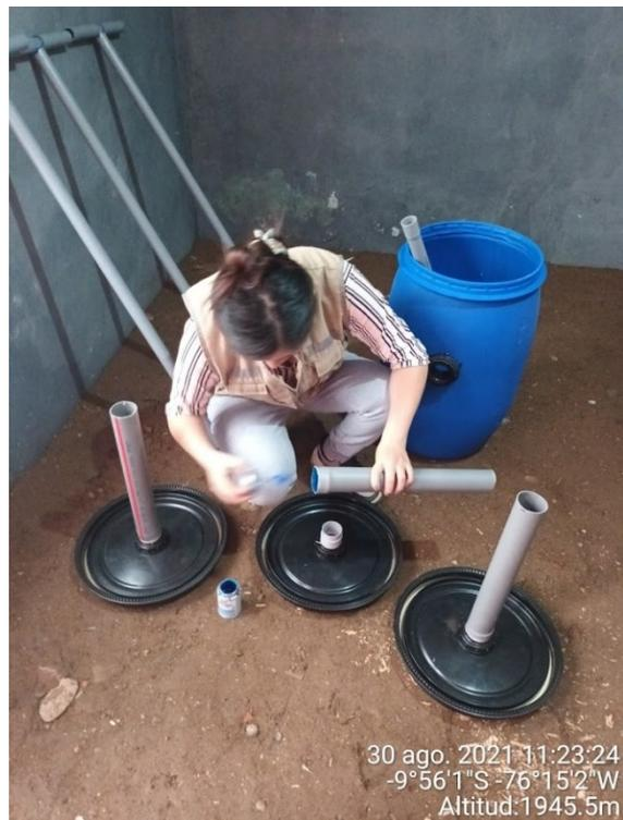
IMAGEN 09 y 10: INSTALANDO EL AGITADOR Y LOS ACCESORIOS CORRESPONDIENTES
