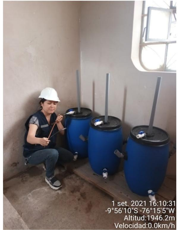
IMAGEN 15 y 16: INSTALANDO LAS MANGUERAS PARA LAS CAMARAS DONDE SE RECEPCIONARAN EL GAS METANO
