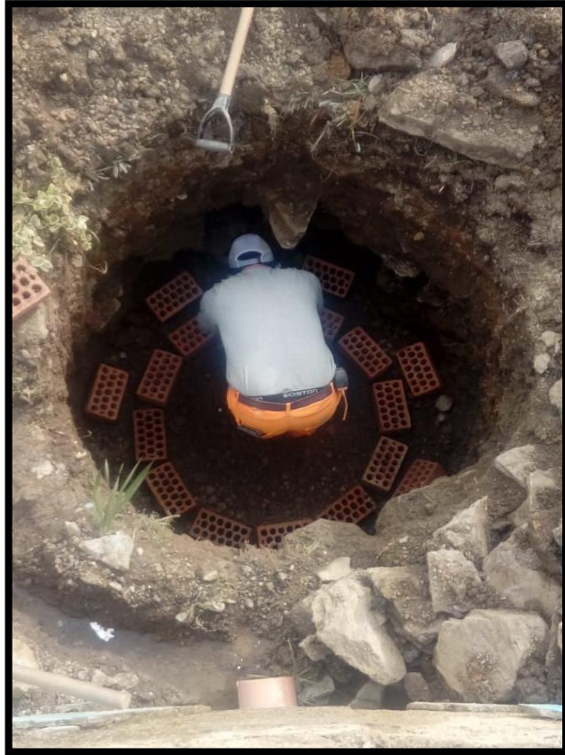
Construcción de pozo de infiltración para absorción de las aguas freáticas provenientes de la subestructura.
