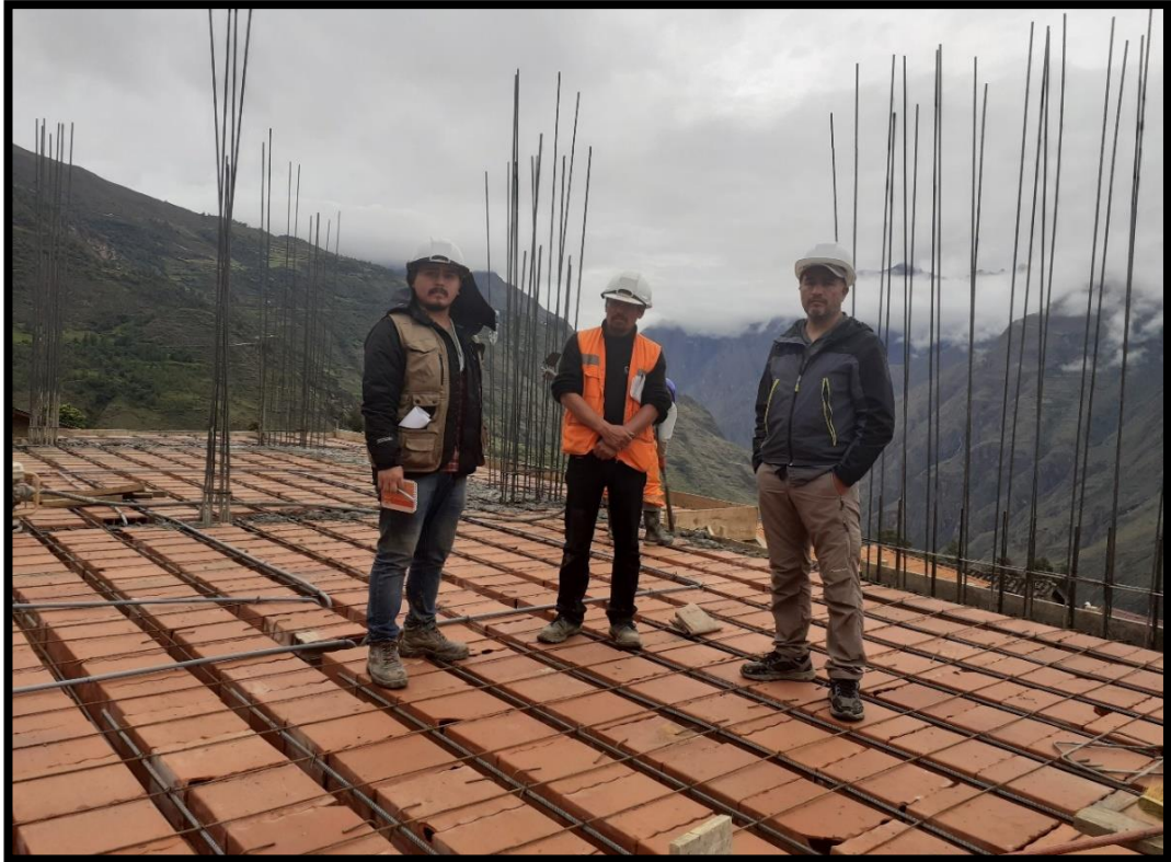
Verificación de trabajos con el supervisor de obra.
