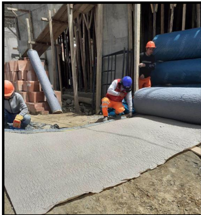
Revisión y preparación de geocompuesto.
