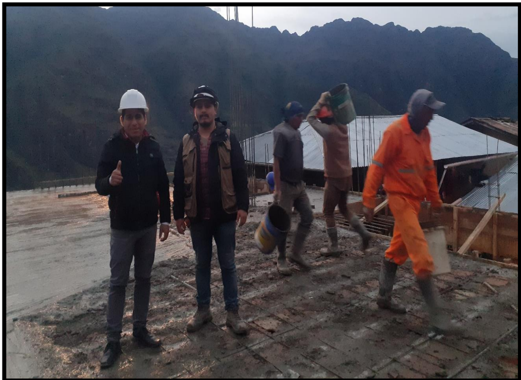
Supervisión y verificación de trabajos para llenado de techo con el residente de obra.
