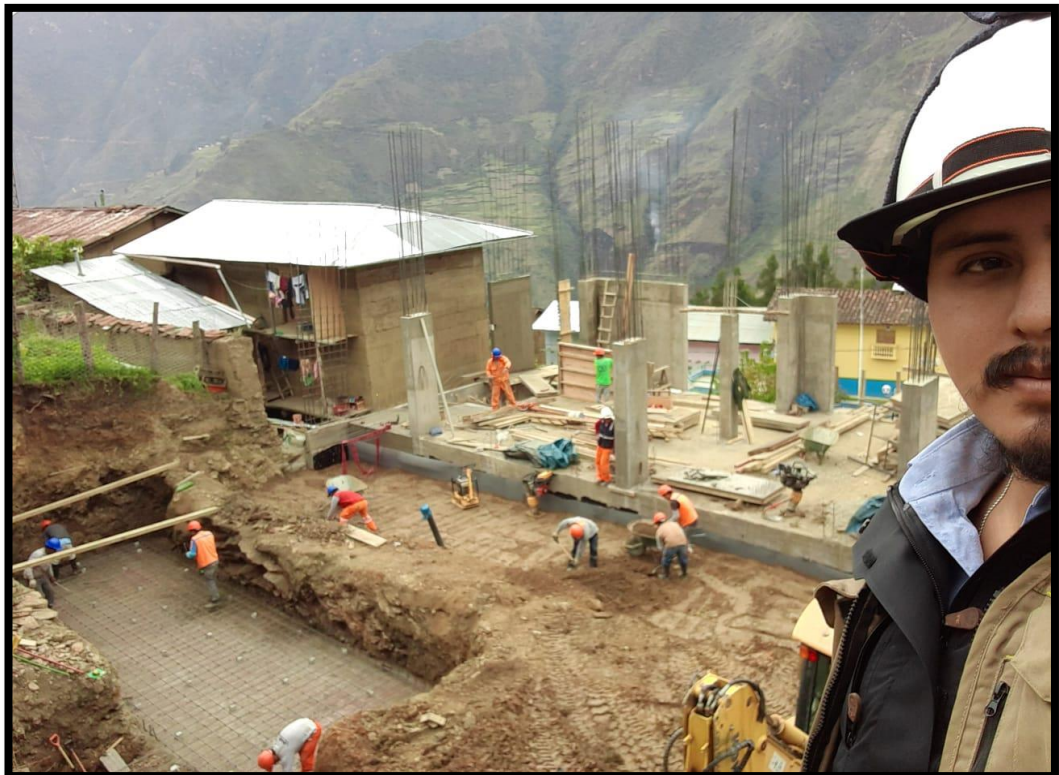
Foto panorámica de los trabajos en obra.
