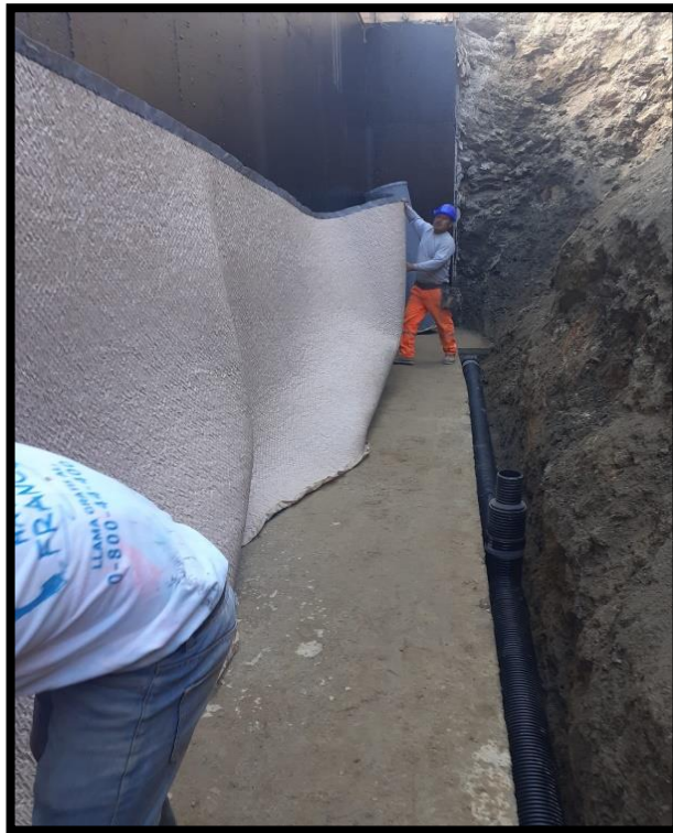
Se puede apreciar los trabajos de tendido de tubería ranurada en base de zapara para evacuación.
