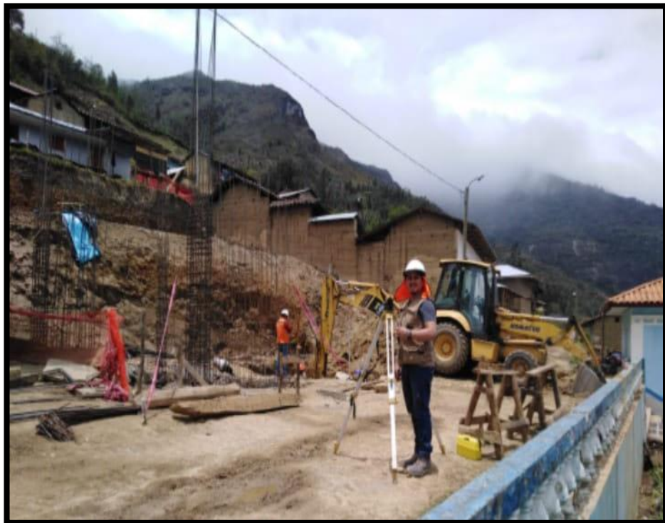
Trabajos de nivelación y topografía para la pendiente de la tubería del drenaje horizontal.
