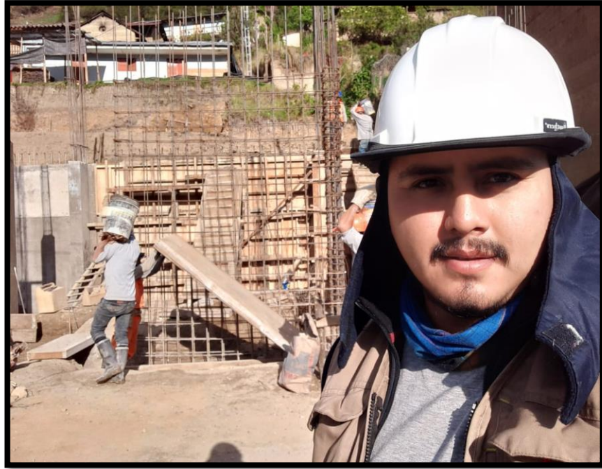
Verificando los trabajos de llenado de concreto en el muro de contención tipo 01.
