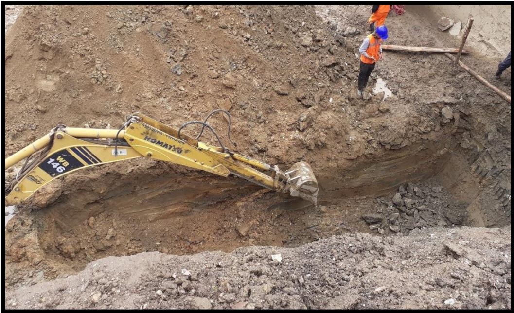
Excavación para la cimentación del muro de contención tipo 01.
