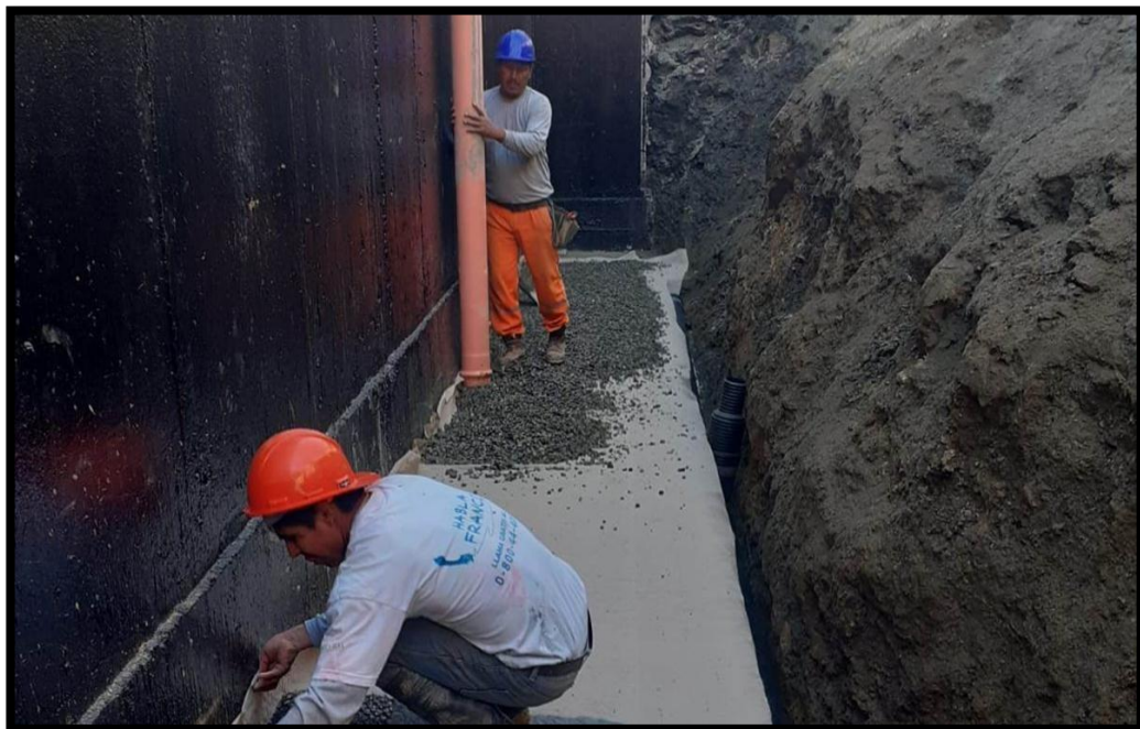
Cama de piedra chancada en base de talón en muro de contención.
