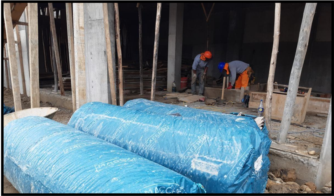
Se aprecia el geocompuesto en rollos después de su descarga.
