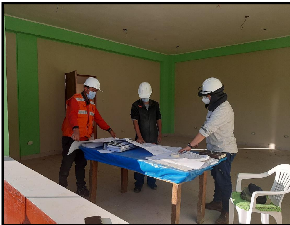
Coordinaciones para los últimos trabajos en obra, para la entrega y recepción.
