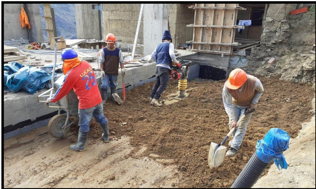
Relleno y compactado mecánico, en zanja de zapata, con material propio seleccionado.
