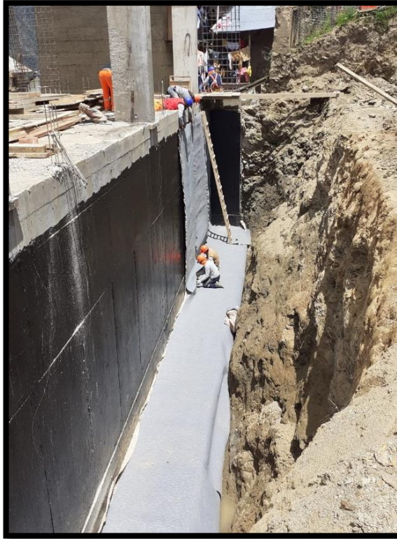
Colocado de geocompuesto en pantalla y talón, envuelto a tubería ranurada.
