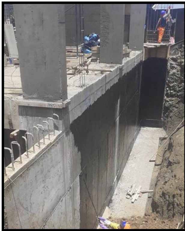
Impermeabilización de muro de contención con bitumen en toda el área de contacto.
