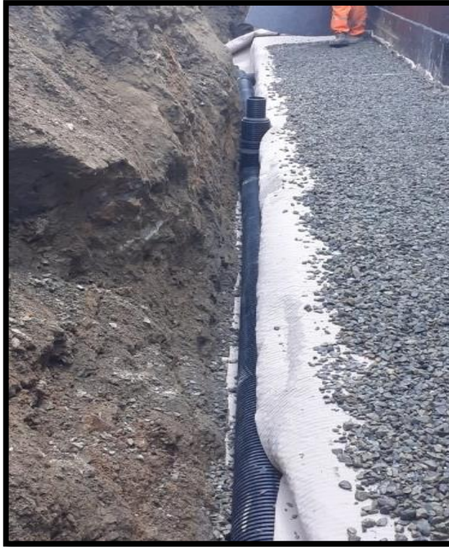
Cama de piedra chancada en base de talón en muro de contención.
