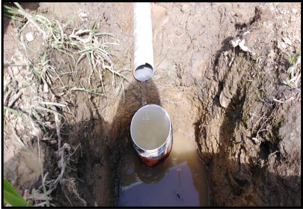
Aforado del caudal de las aguas freáticas in situ.
