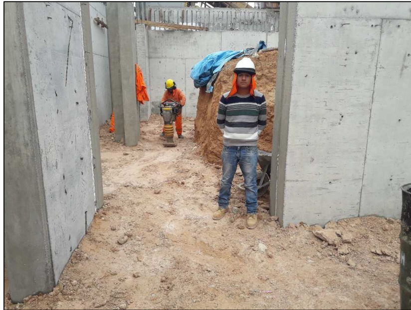
TOMA DE DATOS DE LAS DIMENSIONES DE MUROS ESTRUCTURALES Y COLUMNAS CORRESPONDIENTES AL MODULO II.
