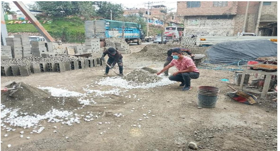
**Mezcla del agregado grueso en un 40% y poliestireno expandido triturado en un 60%**
