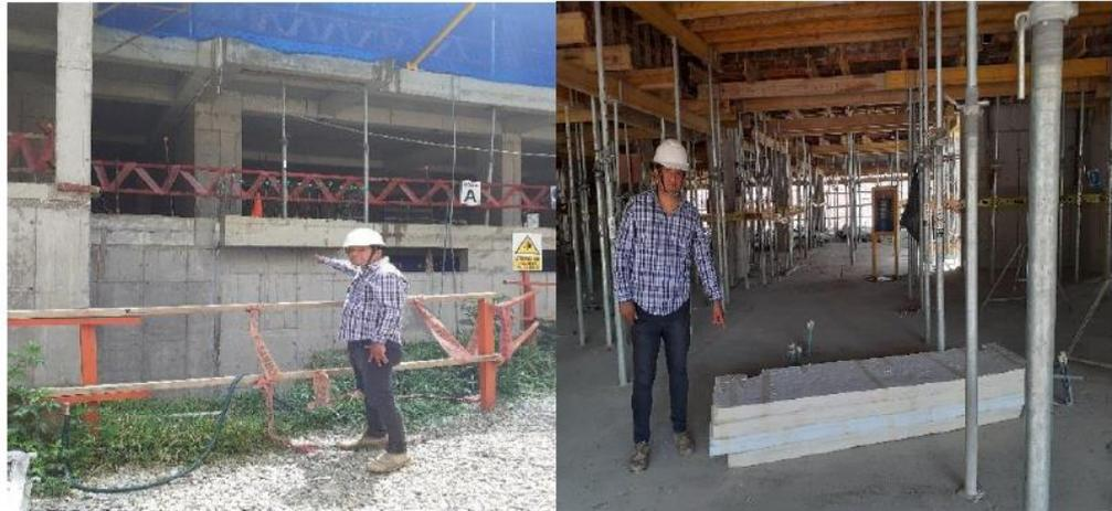
**Figura 15. Planchas de poliestireno expandido reciclado de la infraestructura**
