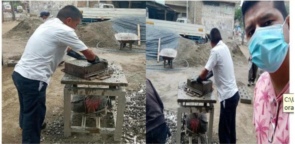
**Figura 19. Uso de la mesa vibradora y los moldes metalicos**
