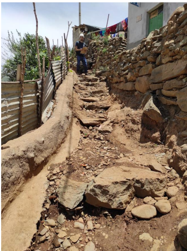
Imagen 9: Se observa material deslizable con dirección a favor de la pendiente. (Febrero – 2020).
