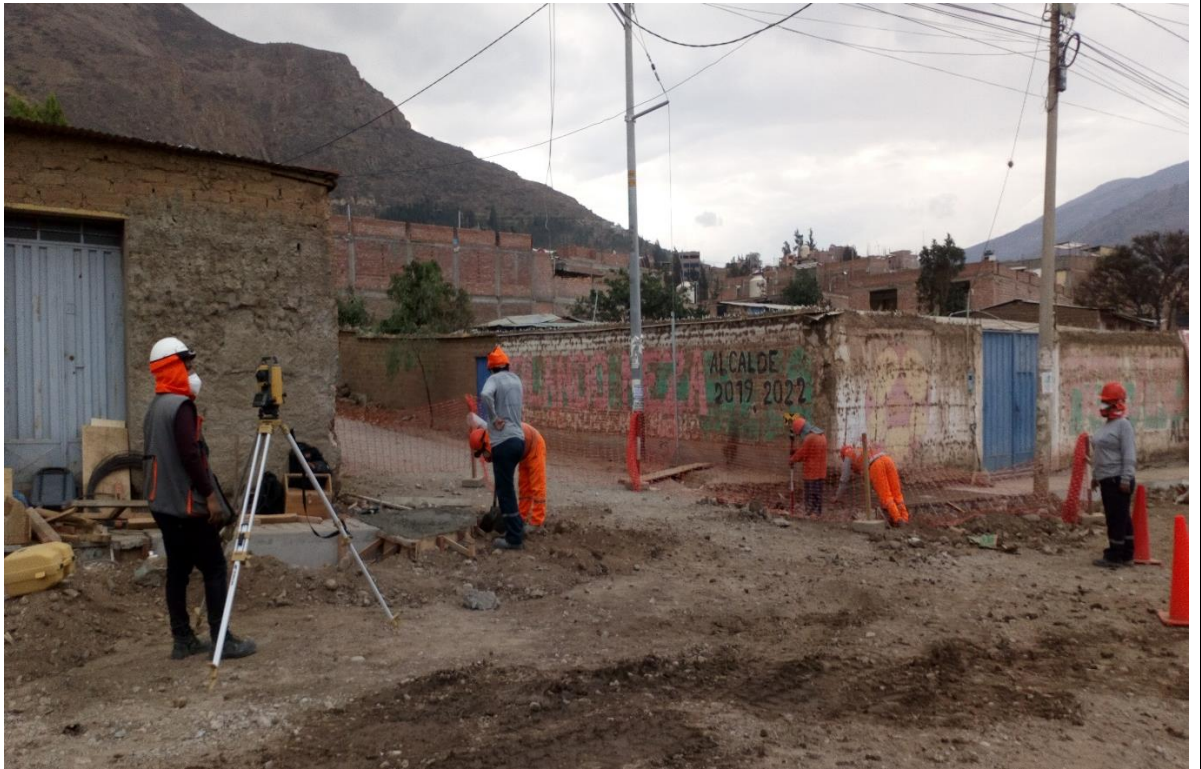
Fotografía 16: Construcción de veredas en la Av. Juan Velasco
