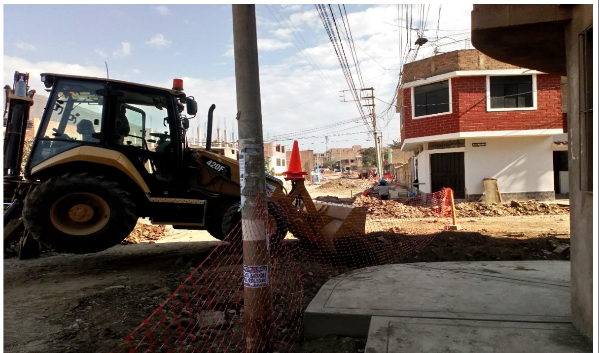
Fotografía 18: Trabajos de excavación con Maquinarias pesadas.
