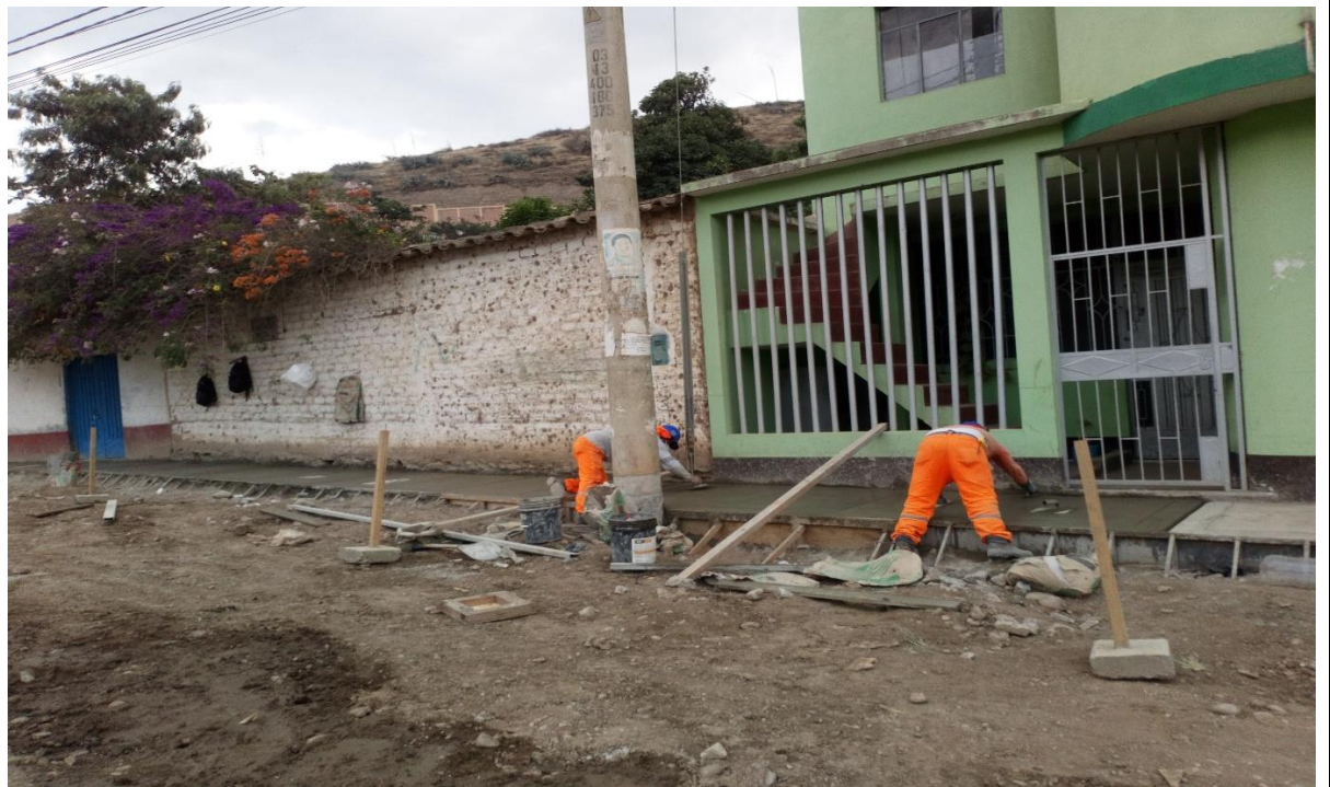
Fotografía 16: Construcción de veredas en la Av. Juan Velasco
