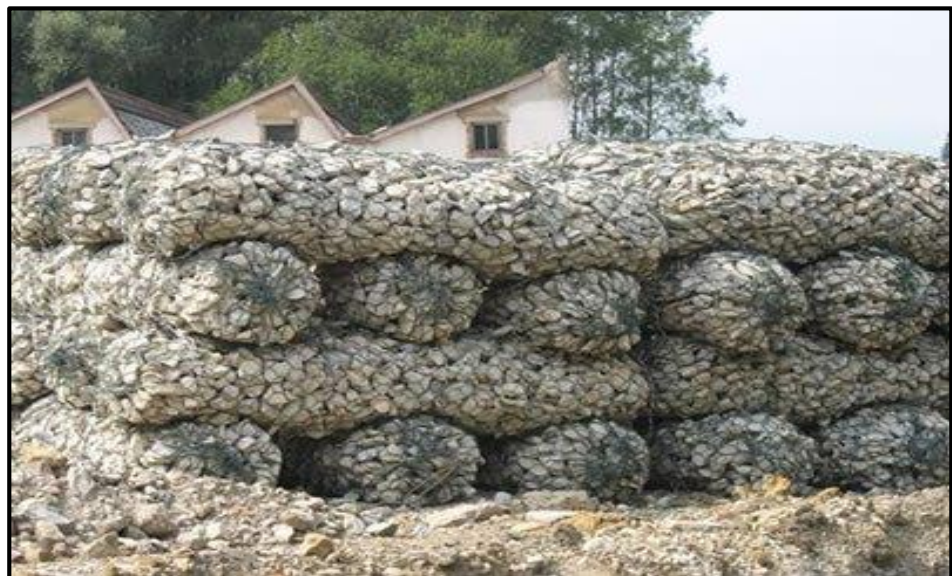
Gráfico 13. Toma fotográfica de gaviones de saco
