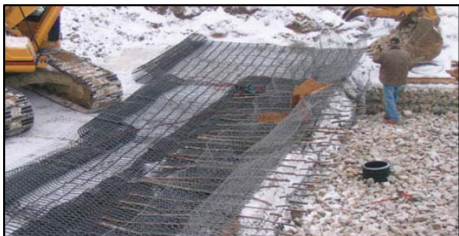
Gráfico 16. Toma fotográfica de colocación de geotextil
