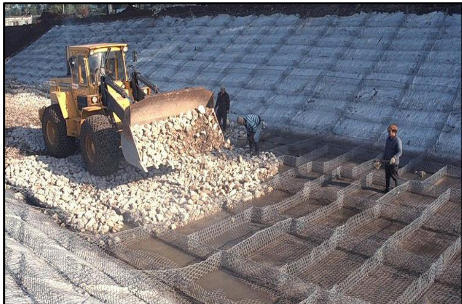
Gráfico 9. Toma fotográfica de instalación de gaviones de colchón
