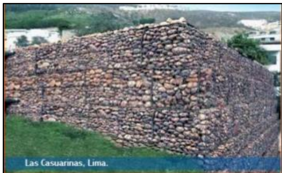
Gráfico 11. Toma fotográfica de gaviones de suelo reforzado
