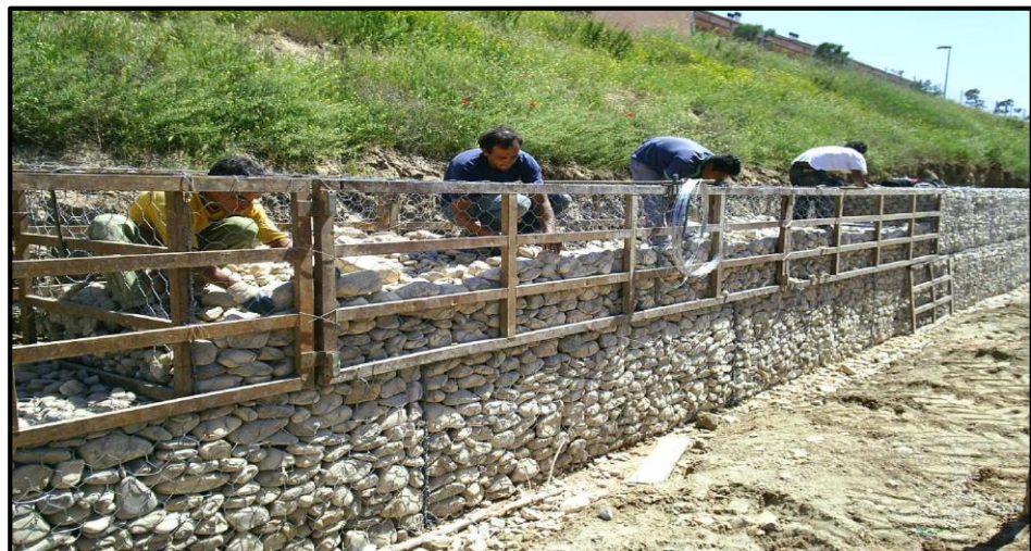
Gráfico 18. Toma fotográfica de relleno de gaviones
