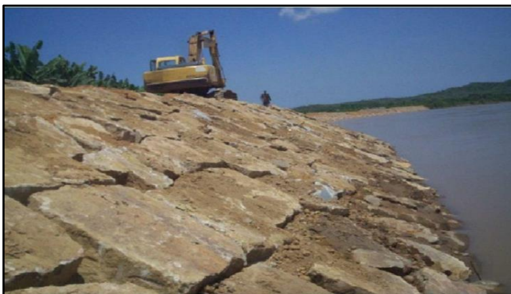
Gráfico 25. Toma fotográfica de una defensa ribereña con enrocado
