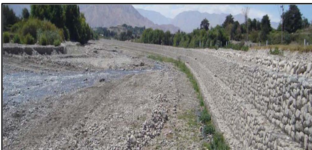
Gráfico 24. Toma fotográfica de una defensa ribereña con gaviones
