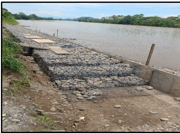
Llenado de gaviones con piedra del río Huallaga
