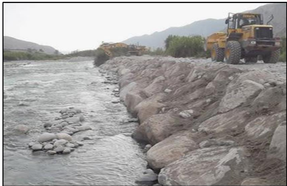
Gráfico 4. Toma fotográfica de un dique de enrocado
