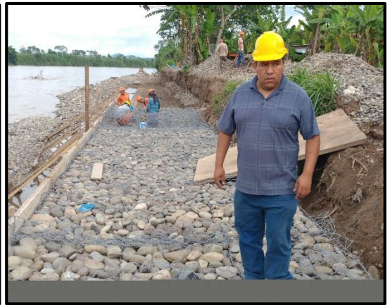
Llenado de gaviones con piedra del río Huallaga
