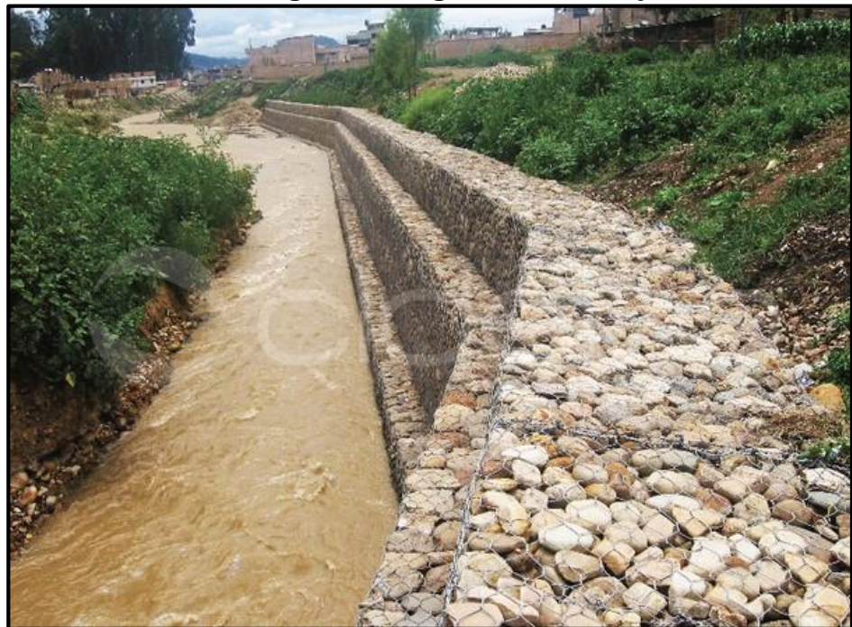
Gráfico 7. Toma fotográfica de gaviones de caja
