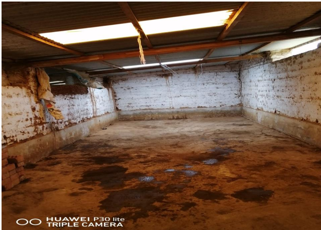
Fotografía 4: Preparación de terreno para la planta de tratamiento de compost (Limpieza de planta de compostaje).
