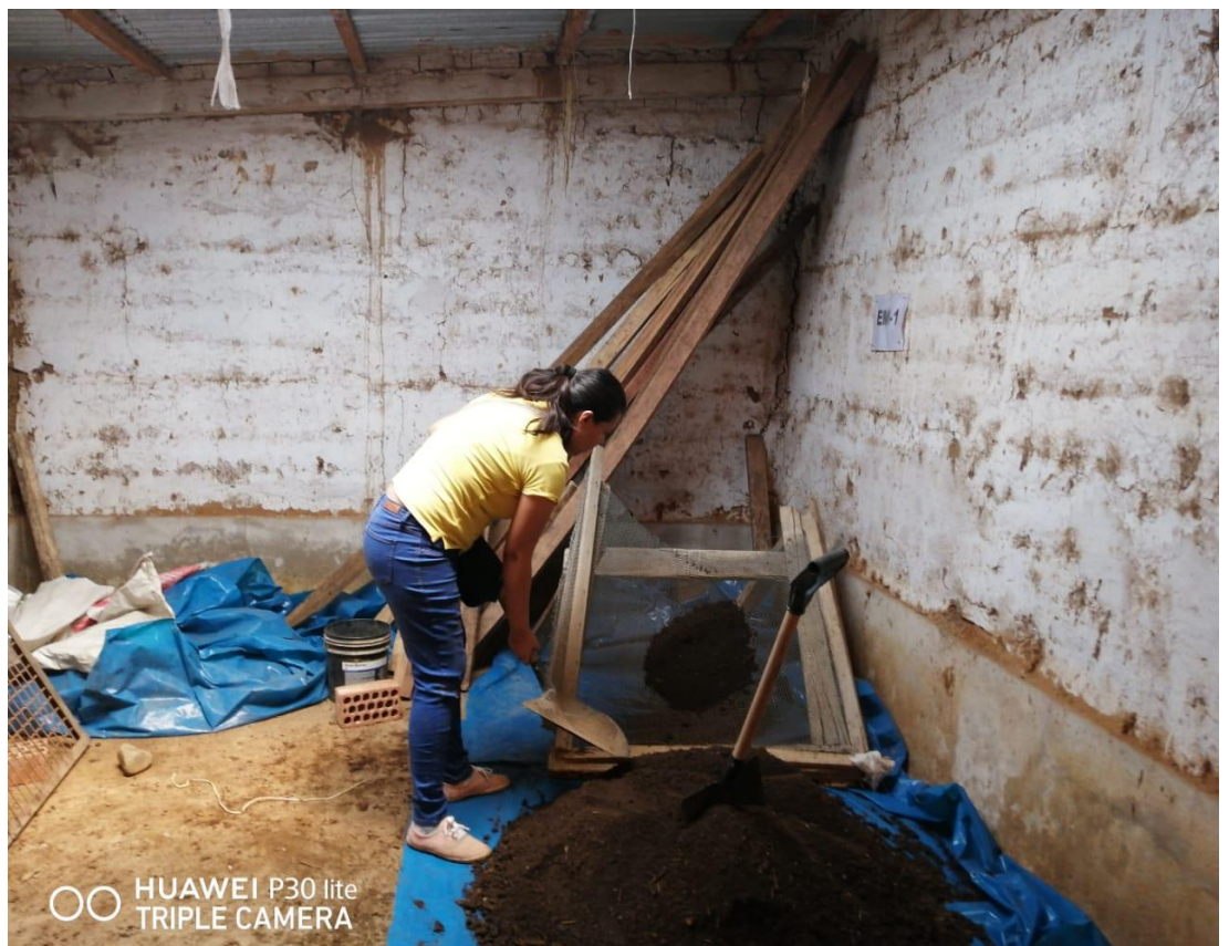
Fotografía 32: Tercer tamizado con zaranda de diámetro.
