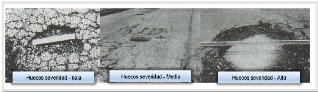
Figura 17. Huecos por severidad
