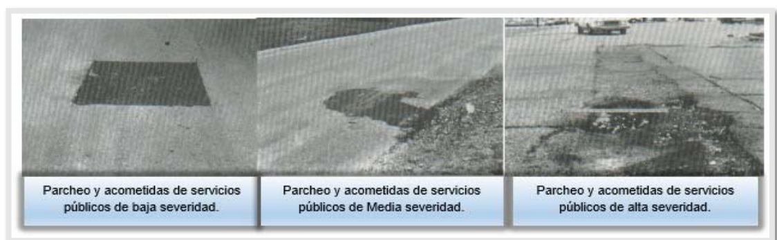
Figura 15. Parcheo y acometidas de Servicios Públicos.
