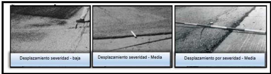
Figura 19. Desplazamiento por severidad
