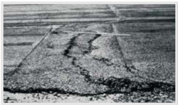
Figura 21. Hinchamiento por severidad alta
