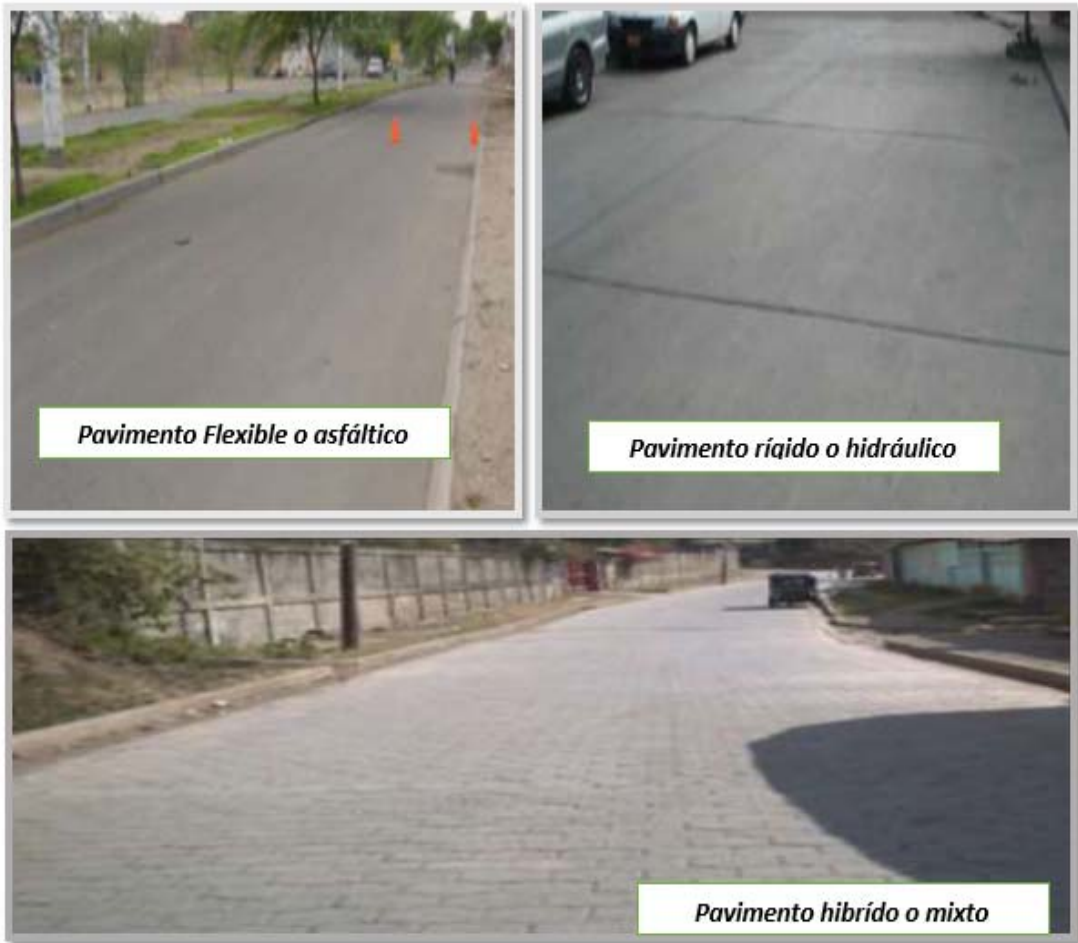
Figura 4. Pavimento asfáltico, Hidráulico y mixto
