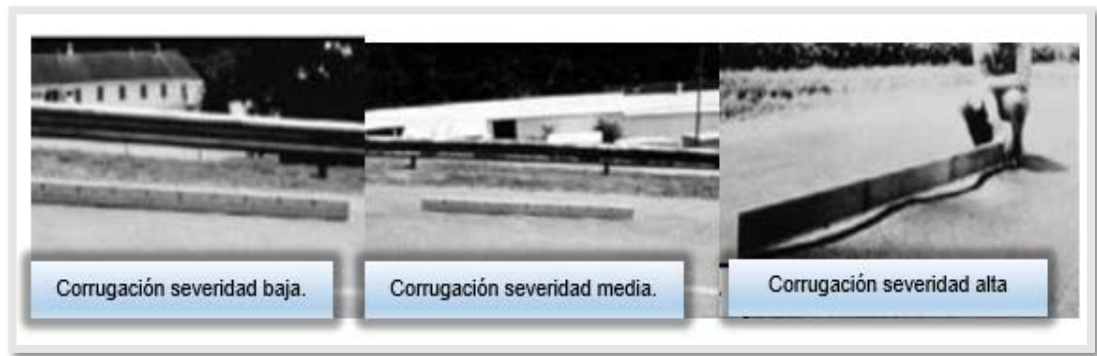
Figura 9. Corrugación de acuerdo a la severidad
