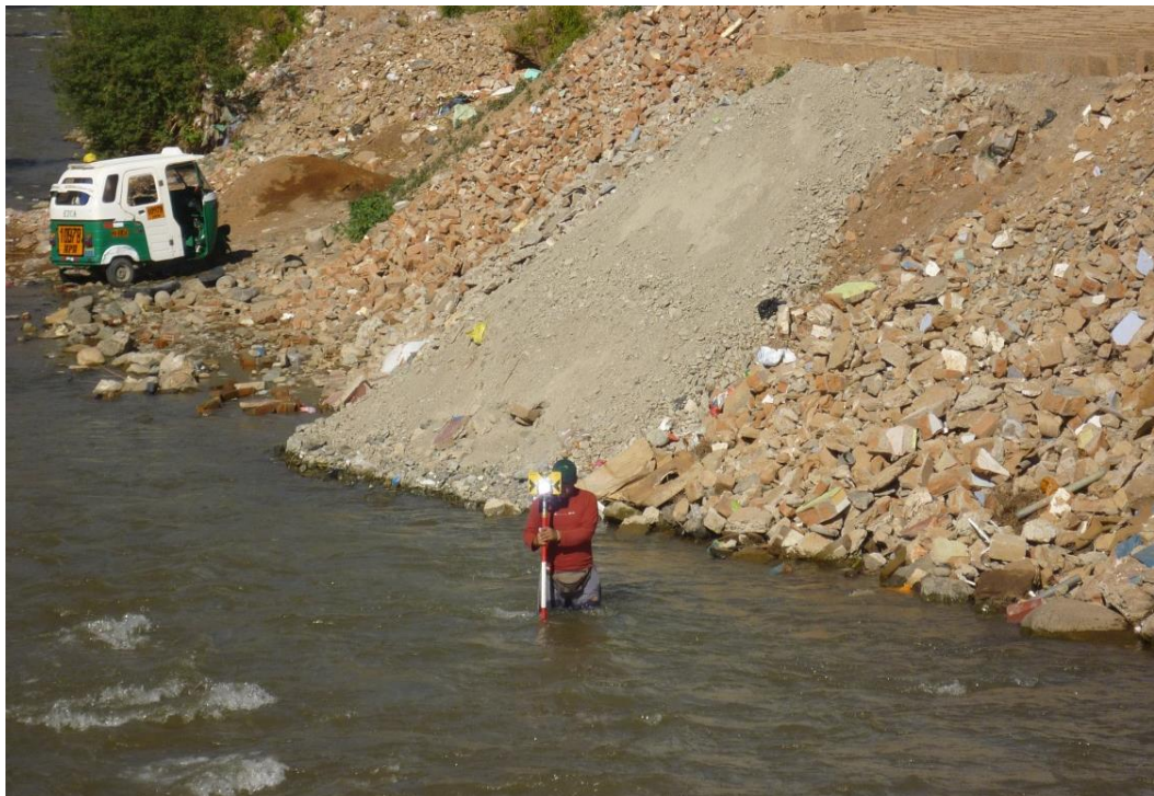
Fotografía N°41: Tesista con el prisma seccionando cauce del rio.
