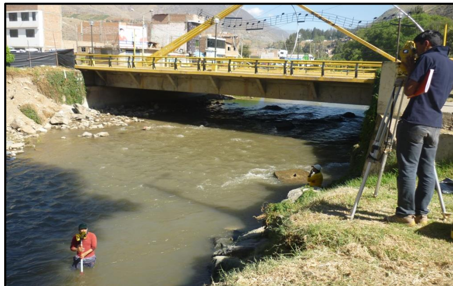
Fotografía N°05: Personal y tesista realizando el levantamiento topográfico, seccionando el rio Higueras.
