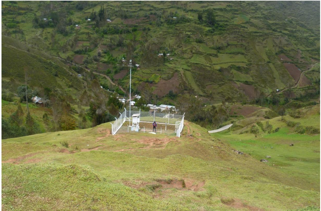
Fotografía N°19: Vista panorámica de la estación meteorológica de Jacas Chico categoría ordinaria, que se encuentra en el distrito de Jacas Chico.
