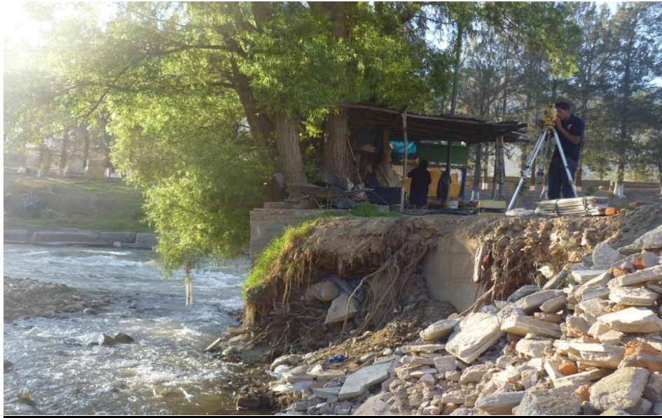
Fotografía N°34: Instalación de la estación total (Estación n°01)
