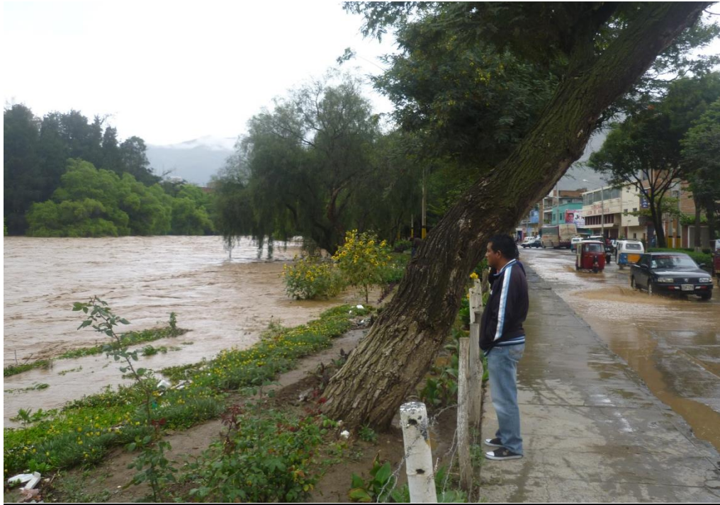
Fotografía N°32: Desborde del rio Huallaga, tramo malecón León de Huánuco.
