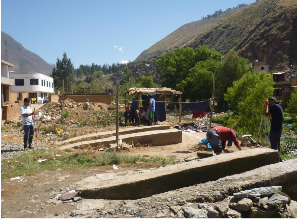
Fotografía N°38: Tesista y personal realizando cambio de estación.
