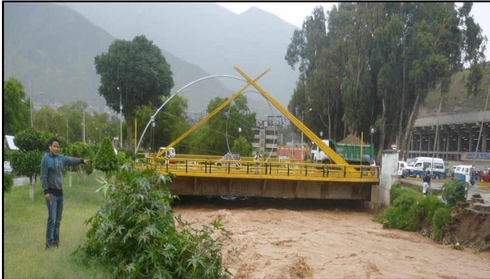
Fotografía N°01: Vulnerabilidad físico-climático del puente León de Huánuco, frente a la crecida de las aguas del rio Higueras.
