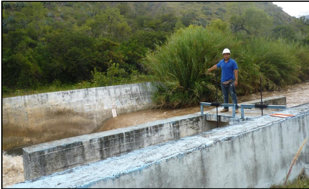
Fotografía N°02: Captación de las aguas del rio Higueras.
