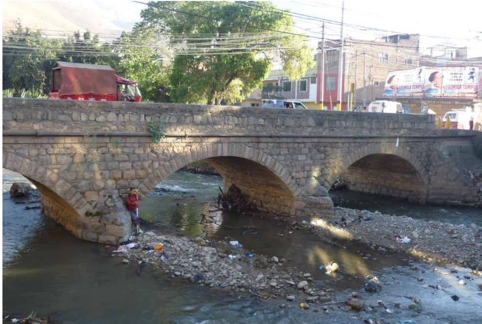
Fotografía N°36: Tesista con el prisma, posicionando en el puente Tingo.
