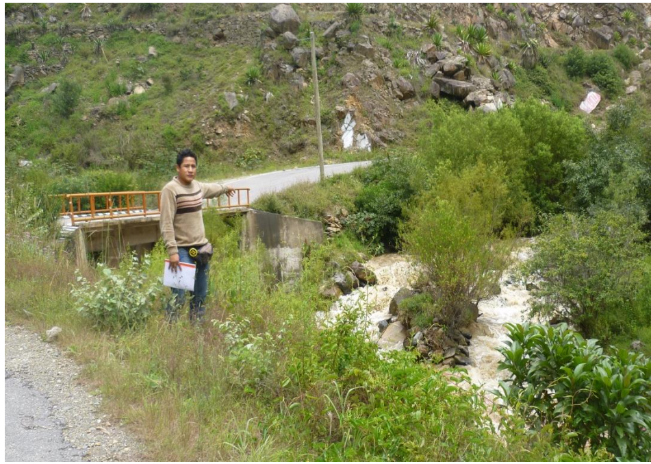
Fotografía N°24: Ríos tributarios del río Higueras.
