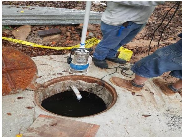
**Ilustración2: Instalación del sistema de bombeo**
