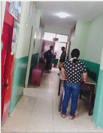
FOTO N°05: Aquí observamos las circulaciones del pasadizo angosta de diámetro aproximado de 1.50mts, impide el tránsito debido a materiales
