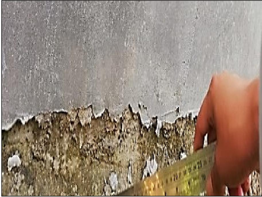
**Foto 13:** observamos la presencia de descascaramiento en el exterior del muro.
