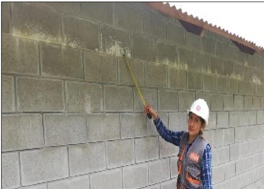
**Foto 10:** Se puede observar la presencia de la eflorescencia en la parte exterior del muro
