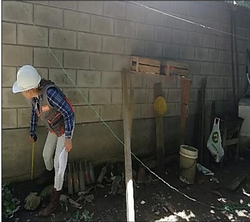
**Foto 07:** Se puede observar la presencia de humedad capilar en la parte inferior del muro.
