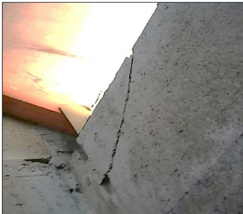
**Foto 12:** Se puede distinguir la presencia de una grieta en la parte interior del muro.
