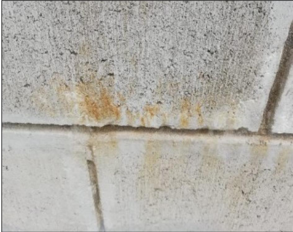
**Foto 09:** Se puede observar la presencia de oxidación en la parte exterior del muro.
