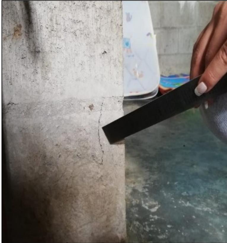
**Foto 11:** Se puede distinguir la presencia de una fisura en la parte interior del muro.
