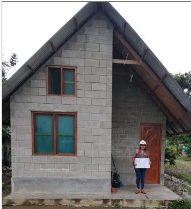
**Foto 06:** Se puede observar la estructura de la vivienda que el muro es de albañilería armada.
