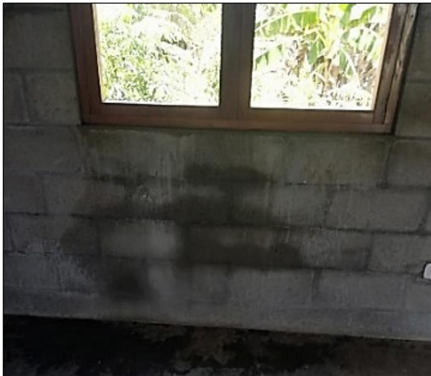
**Foto 08:** Se puede apreciar la presencia de humedad de filtración en la parte interior del muro.
