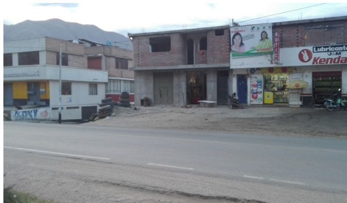
Vulcanizadora ubicada en la carretera central - paradero 11
