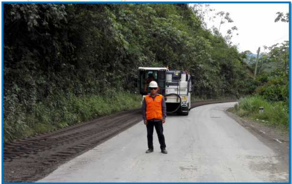
VISTA: RECICLADO DE PAVIMENTO FLEXIBLE–EQUIPO, RECICLADORA WIRTGEN W240.
