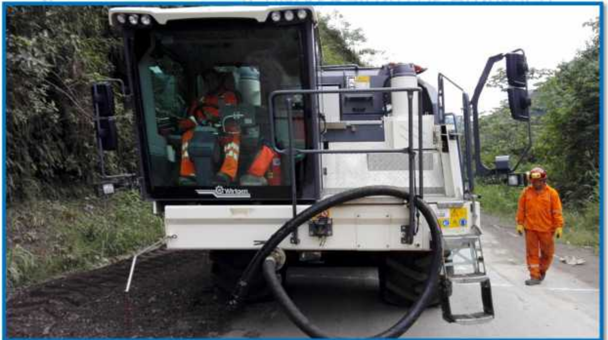
VISTA: EQUIPO DE RECICLADO DE PAVIMENTO FLEXIBLE – RECICLADORA WIRTGEN W240.
