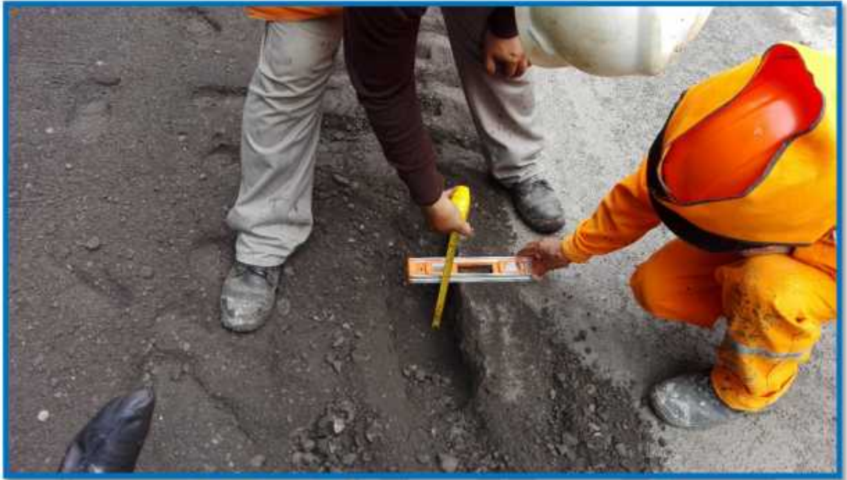
VISTA: INSPECCIÓN DEL ESPESOR RECICLADO Y UNIFORMIDAD DEL MATERIAL.
