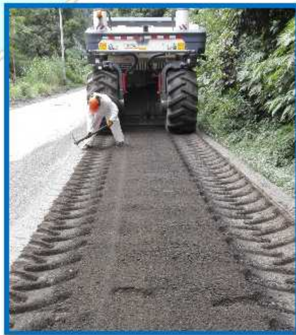
VISTA: INSPECCIÓN PARA VERIFICAR LA HOMOGENEIDAD DEL MATERIAL RECICLADO.
