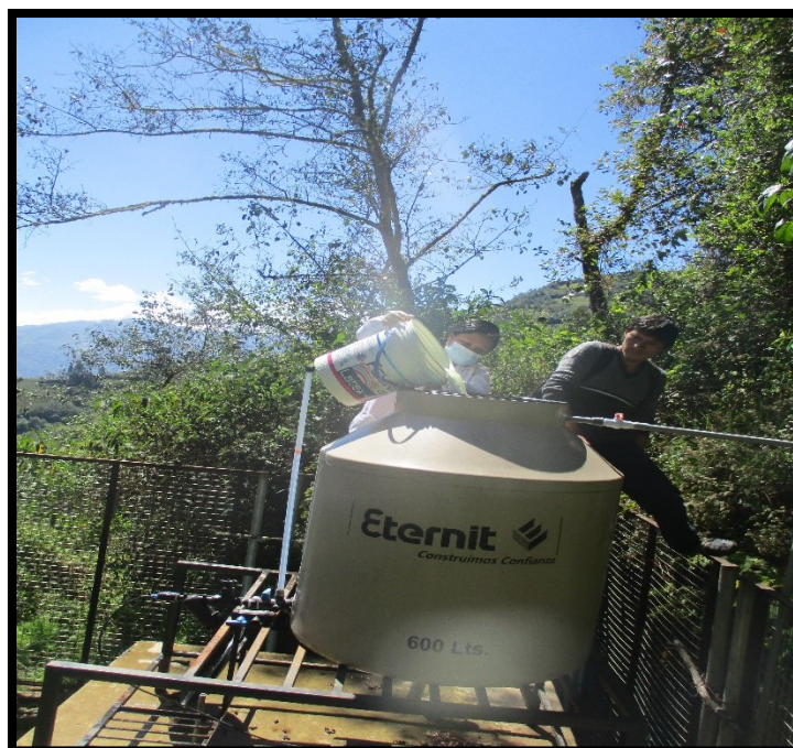
Fotografía 5: Vista fotográfica de la recarga de cloro residual de abastecimiento de agua.
