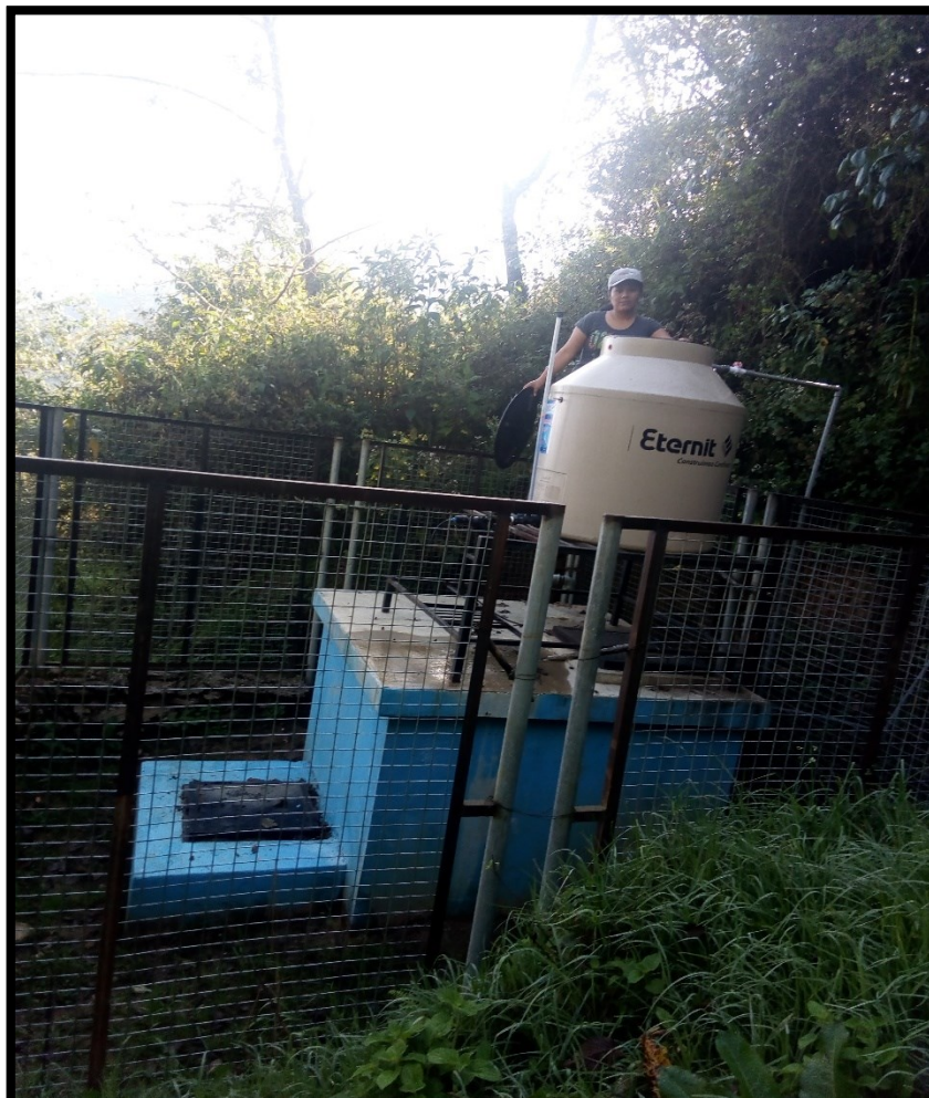
Fotografía 7: Vista fotográfica del sistema de cloración autocompensante del sistema de abastecimiento de agua.
