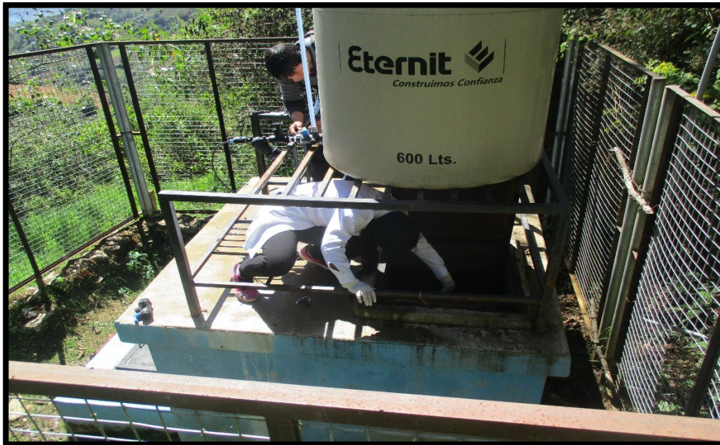
Fotografía 7: Vista fotográfica del sistema de cloración autocompensante del sistema de abastecimiento de agua.
