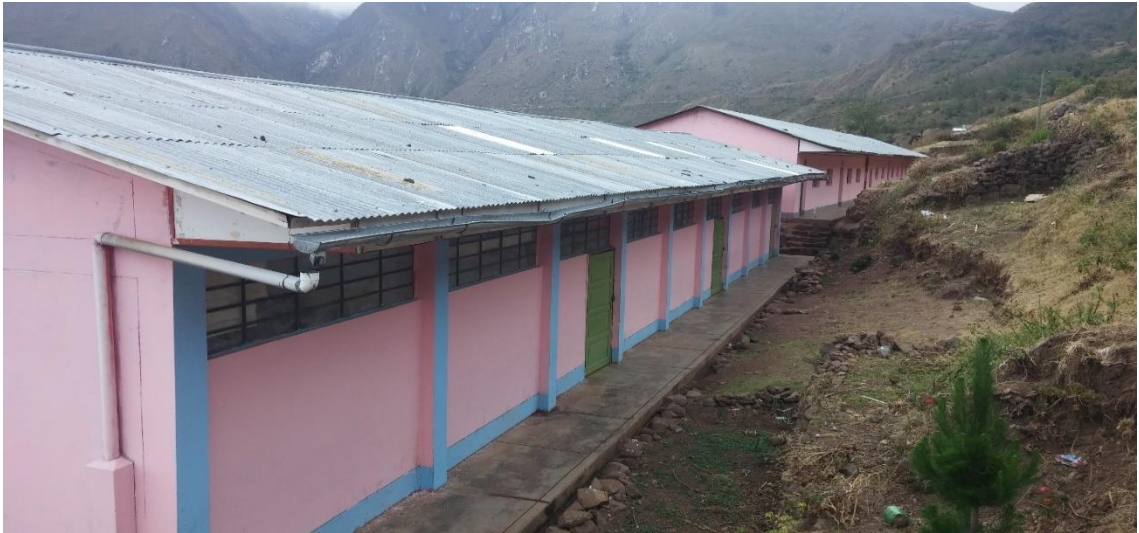
Foto N° 12: Vista de los Módulos primaria y secundaria
