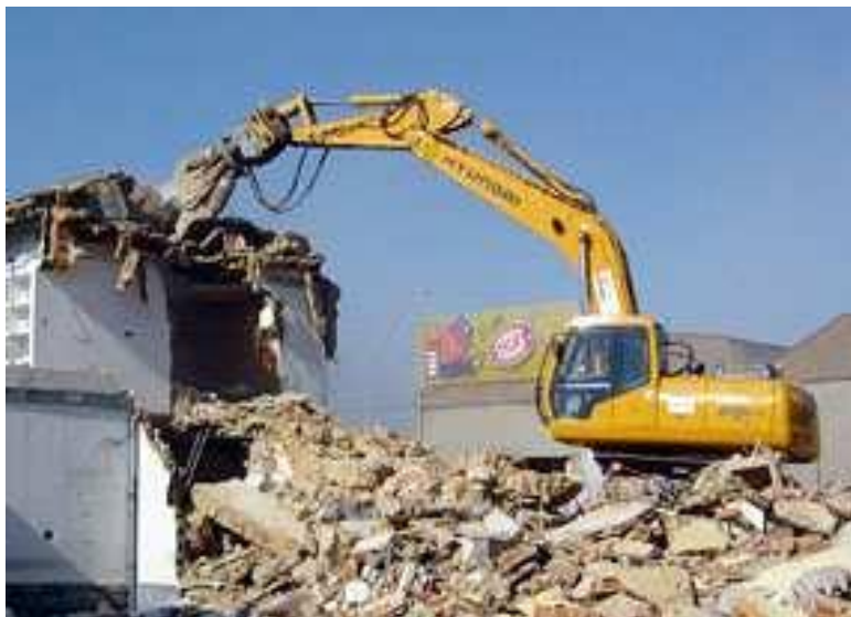
Foto N° 13: Las demoliciones mecánicas con retroexcavadora, equipadas con pinzas demoleadoras, ofrecen un alto rendimiento, además de un nivel considerable de seguridad.
