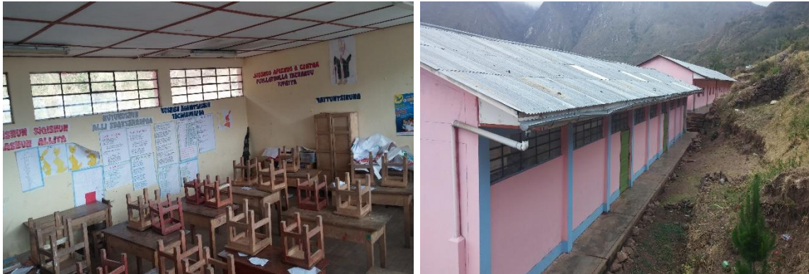
Foto N° 10,11: La estructura del módulo II – sistema estructural de Albañilería Confinada.
