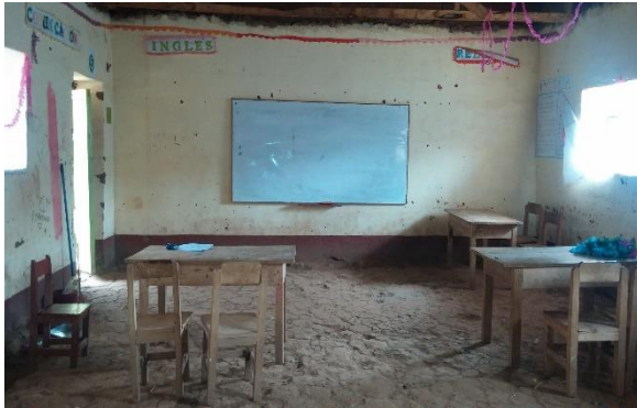
Foto N° 8,9: La estructura del módulo I – sistema estructural de tapial
