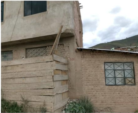
Losas a desnivel entres viviendas.
