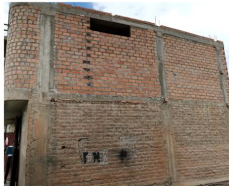
Uso de ladrillo pandereta en muros portantes.
