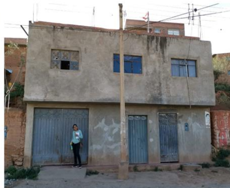
Vanos no continuos en elevación.
