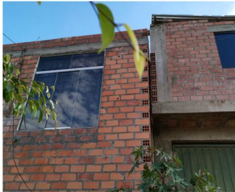
Uso de ladrillo pandereta para muros portantes.
