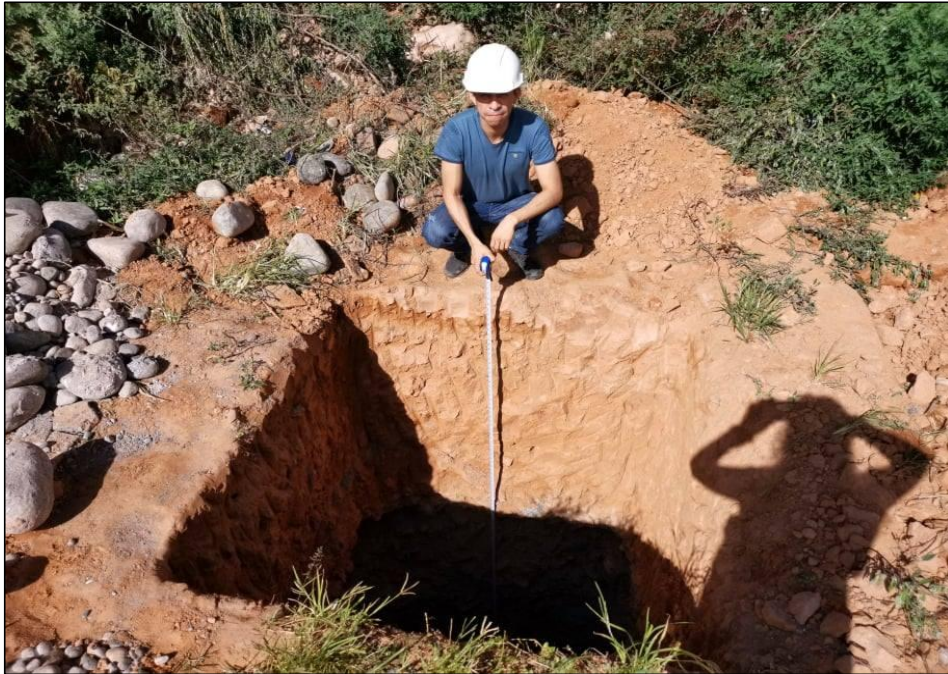
Imagen 05: Verificación de la calicata 01, obtención de medidas y materiales.
