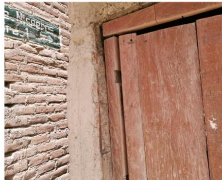
Acero de refuerzos expuestos.
