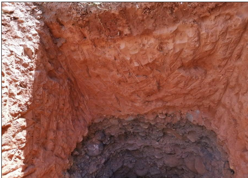
Imagen 03: El primer estrato se observa que viene hacer un suelo orgánico de espesor de 0.30m y el segundo estrato de observa que es arena arcillosa de espesor de 0.70m.
