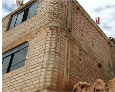
Muro portante con ladrillo pandereta.
