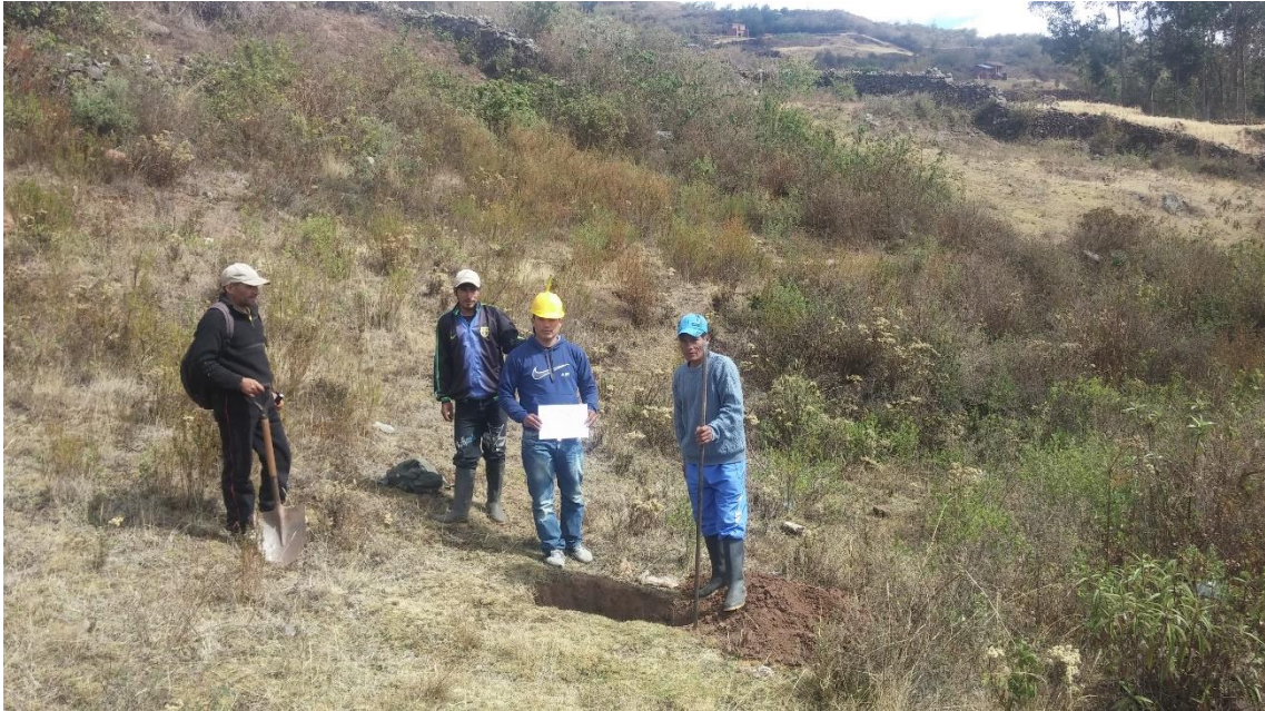
Fotografía 3. En la fotografía podemos apreciar la excavación de la calicata N°1, que se llevó a cabo gracias a la ayuda y colaboración de los pobladores de la zona.
