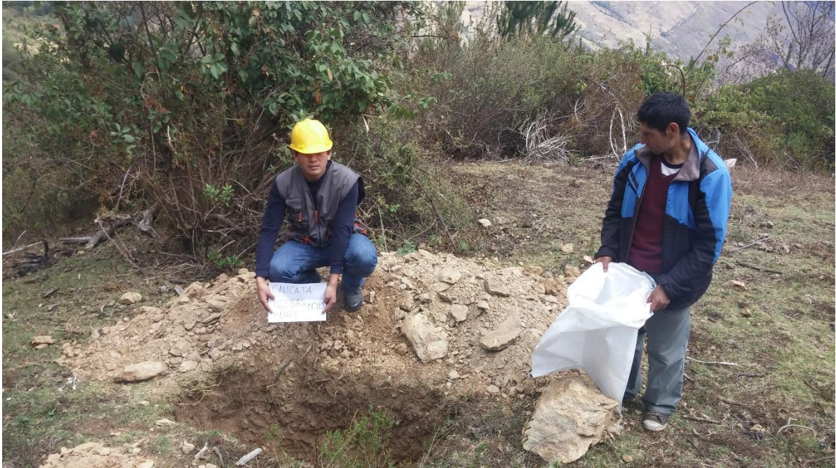
Fotografía 5. En la fotografía podemos apreciar la excavación de la calicata N°3 y procedemos a la toma de muestras para los ensayos respectivos.
