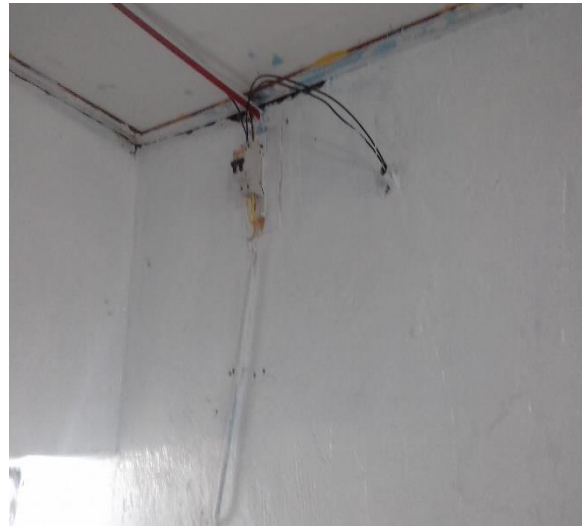
Fotografía 18. En dicho ambiente también se puede observar las malas instalaciones eléctricas exponiendo a los niños a un peligro constante.
