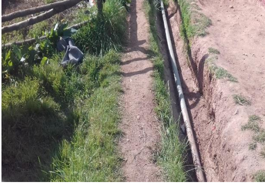
Fotografía 14. Observamos que por el centro del pasadizo hay una zanja abierta por donde pasa la tubería sanitaria de la cocina, en conclusión es un espacio muy peligroso para que transite un niño, ya que está expuesto a un accidente.
