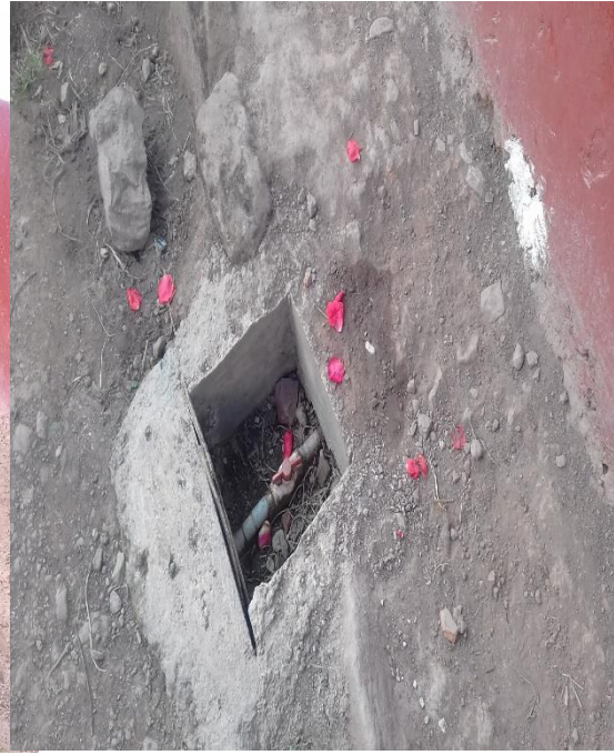
Fotografía 14. Observamos que por el centro del pasadizo hay una zanja abierta por donde pasa la tubería sanitaria de la cocina, en conclusión es un espacio muy peligroso para que transite un niño, ya que está expuesto a un accidente.
