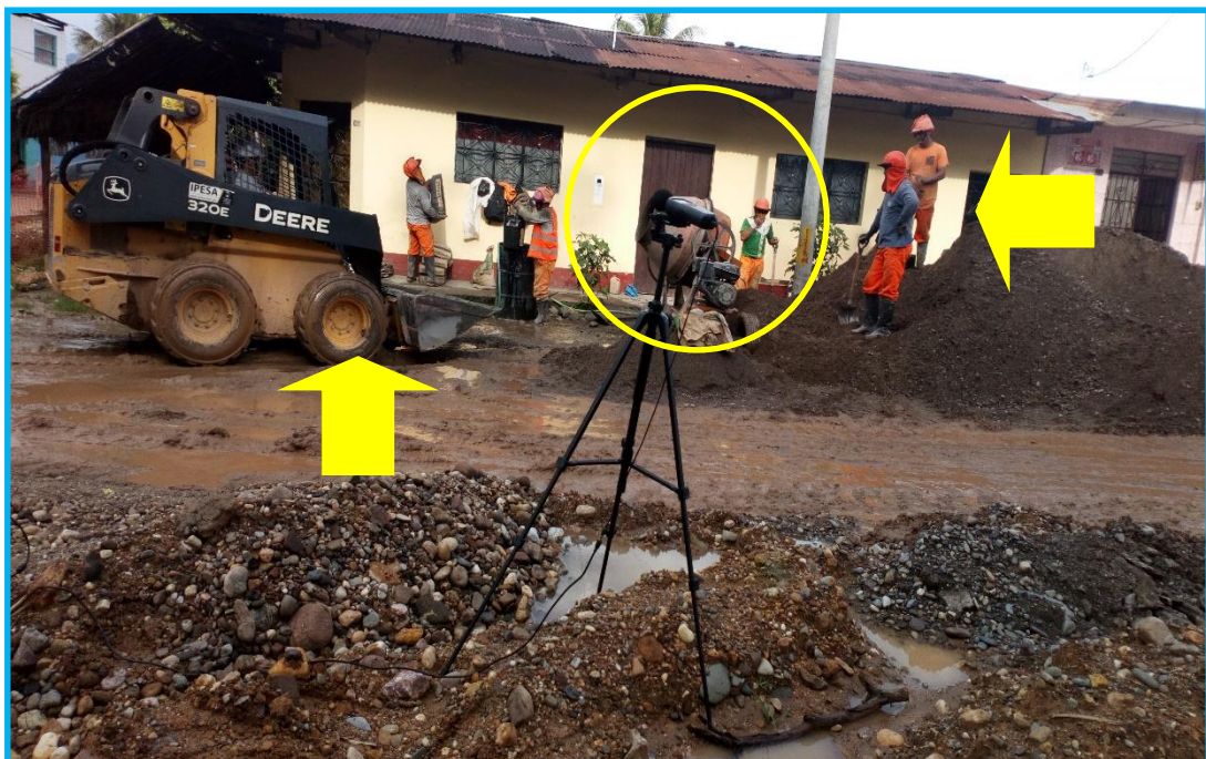
Fotografía 08: Minicargador, mezcladora fuentes generadoras de ruido en el punto de monitoreo 02
