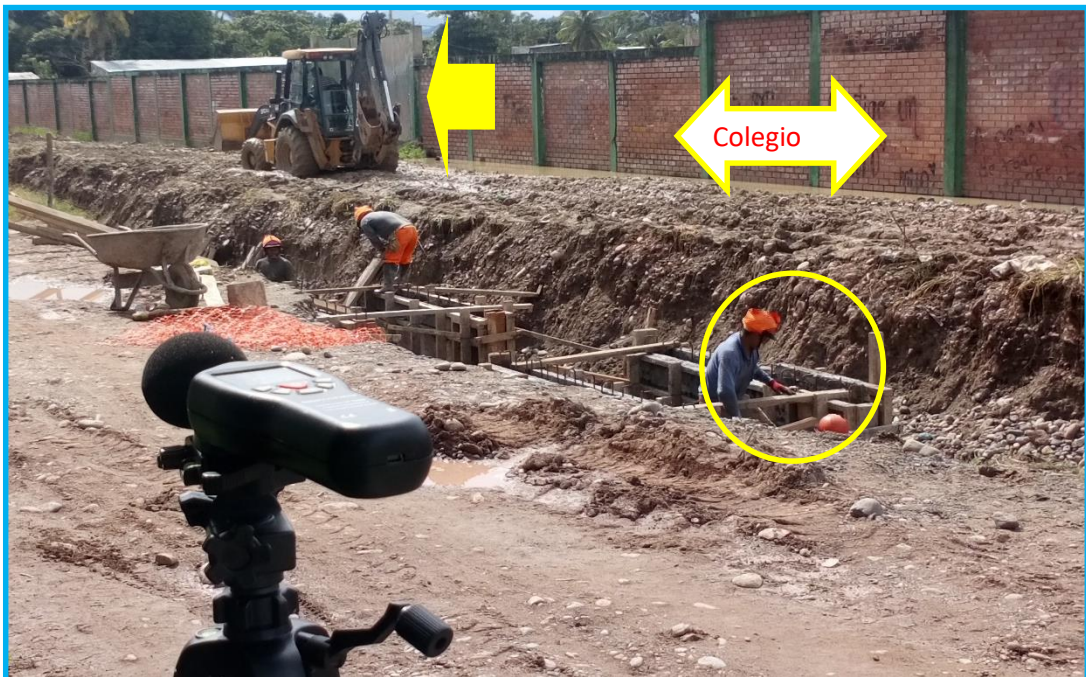
Fotografía 14: Retroexcavadora y equipos ligeros fuentes generadoras de ruido en el punto de monitoreo 05.
