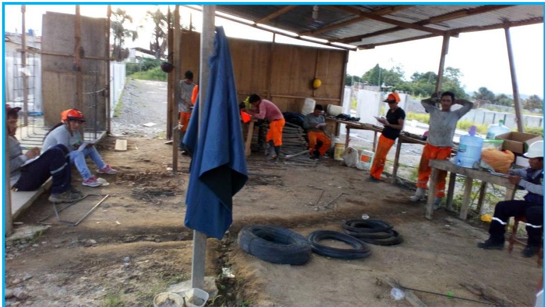
Fotografía 04: Personal de Obra de la cuadrilla encargado de tejer y vaciar los bloques de concreto siendo encuestado.
