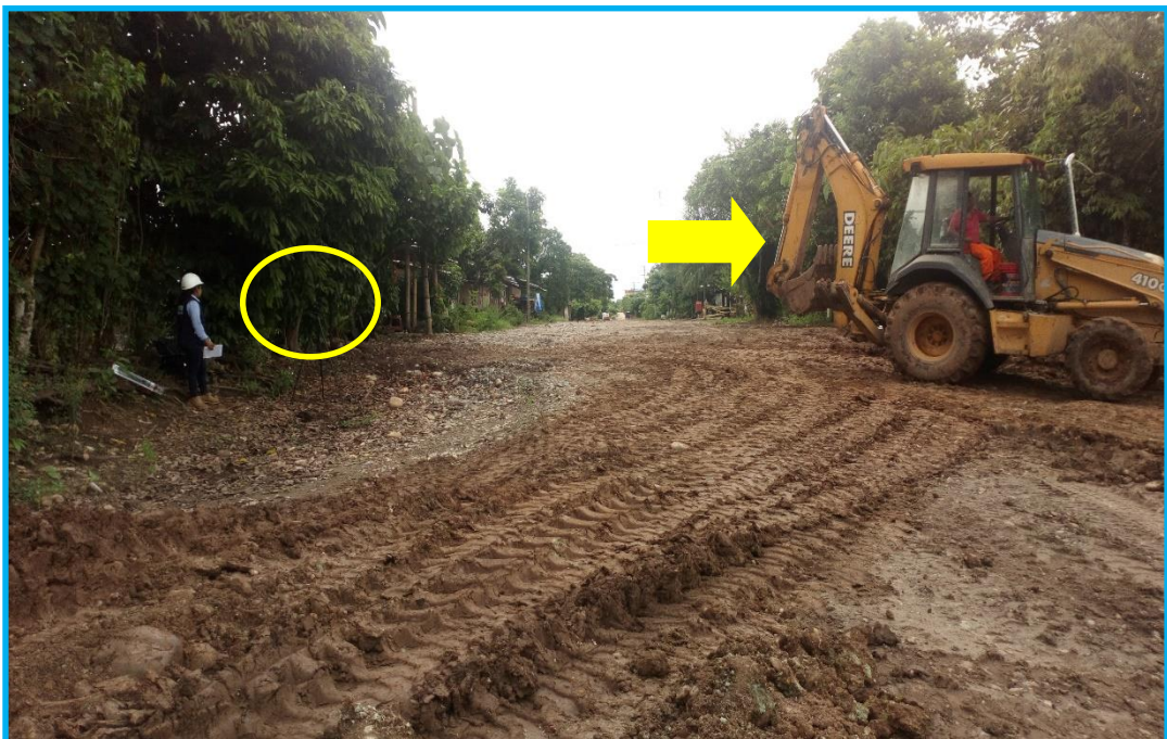
Fotografía 06: Retroexcavadora fuente generadora de ruido en el punto de monitoreo 01.
