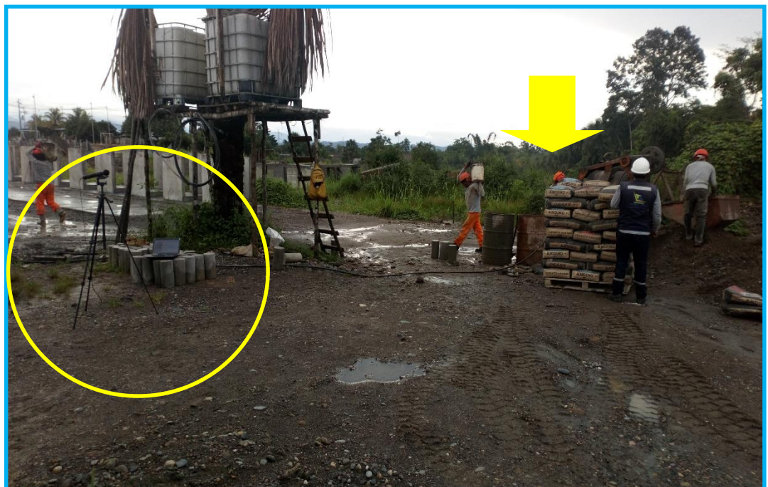
Fotografía 10: Monitoreando el ruido generado por la mezcladora durante el vaciado de los bloques de concreto.
