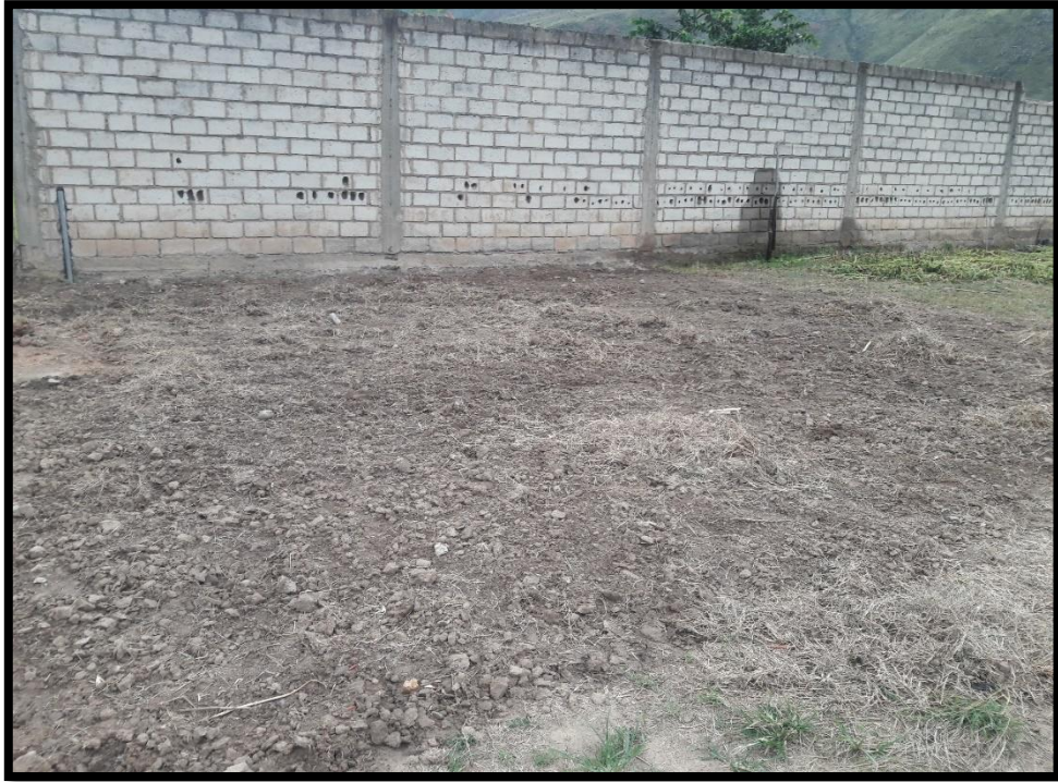
Limpieza y nivelado del terreno en 70 metros cuadrados
