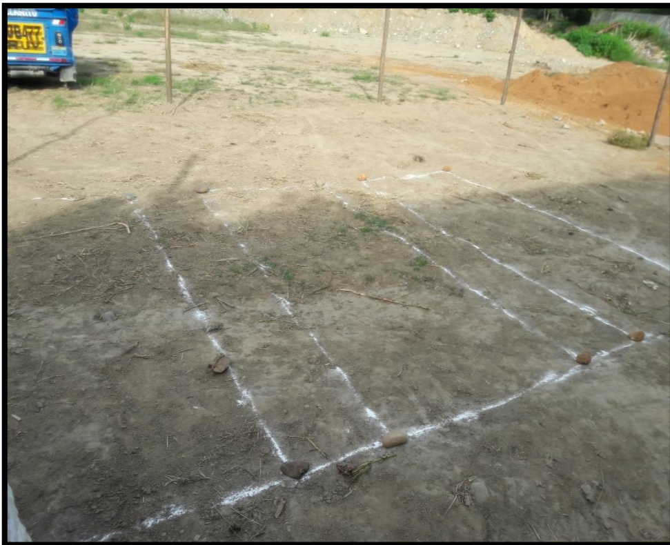
Cercado de terreno con listones 1.80 metros.
