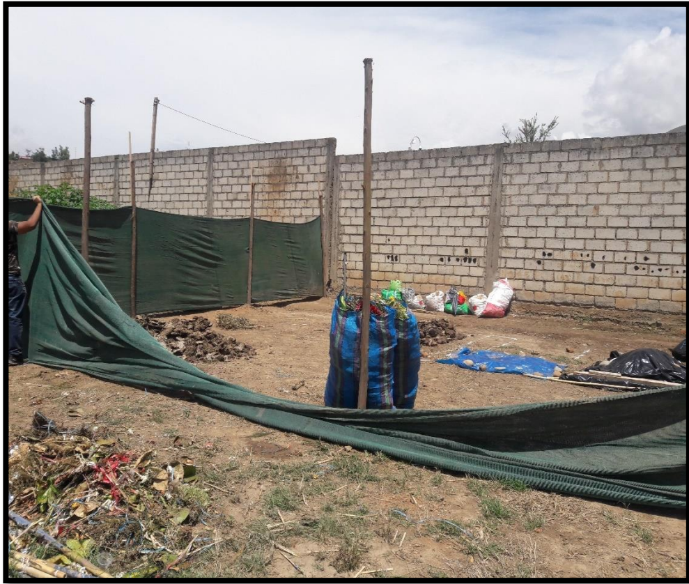
Colocación de mallas rashell
