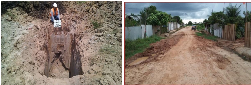
Fig. 5.1.1.2.1. Imágenes del tipo de estrato que será de apoyo a la subrasante.
