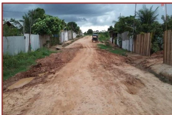
Fig. 2.6.1. Imágen de la carretera actual existente en la zona del proyecto.
