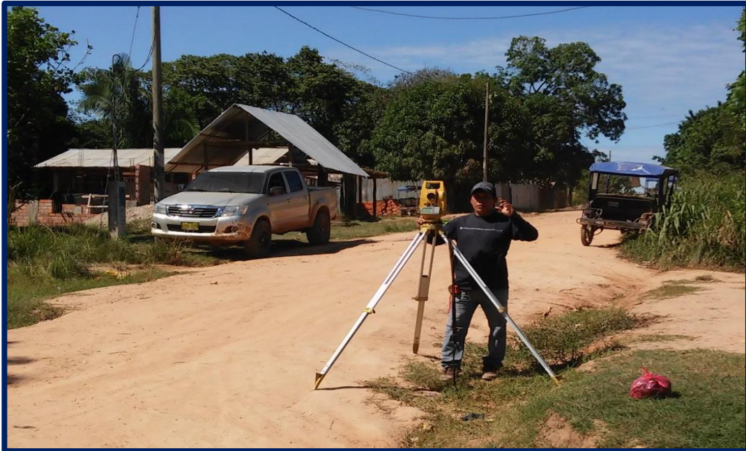
FOTO 01: RESPECTIVO LEVANTAMIENTO TOPOGRAFICO PARA EL MEJORAMIENTO DEL CAMINO VECINAL, AV. BELISARIO PANDURO – PROGRESIVA 00+200.00
