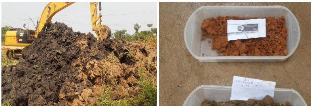
Fig. 3.6.2. Imágenes de compatibilización de los estribos del puente, entre el campo y el laboratorio respectivamente.
