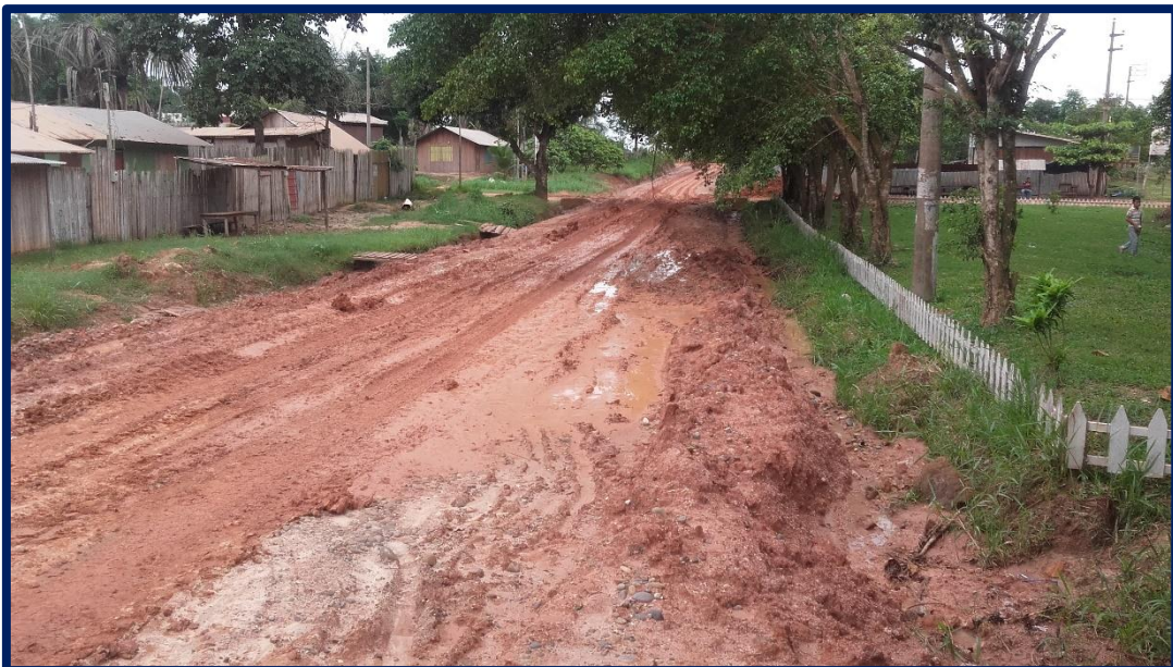
FOTO 02: TRAMO INICIAL DEL PROYECTO AV. BELISARIO PANDURO – SE OBSERVA EL MAL ESTADO DE LA VIA DEBIDO A LAS PRECIPITACIONES, FALTA DE SISTEMA DE DRENAJES – PROG. 00+000.00
