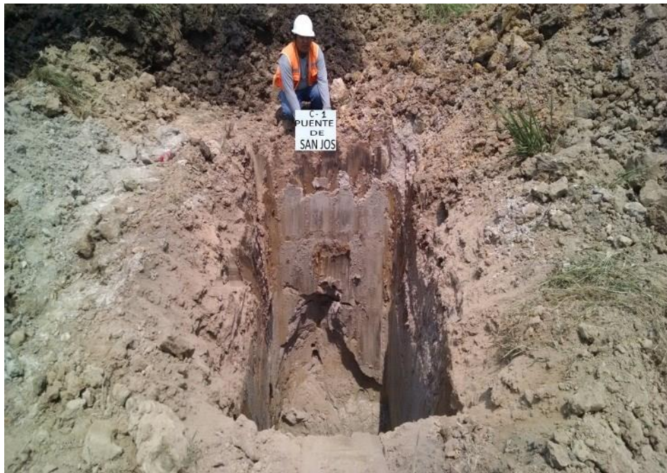
Fig. 2.5.1. Imágenes del talud de corte existente en la zona del proyecto.
