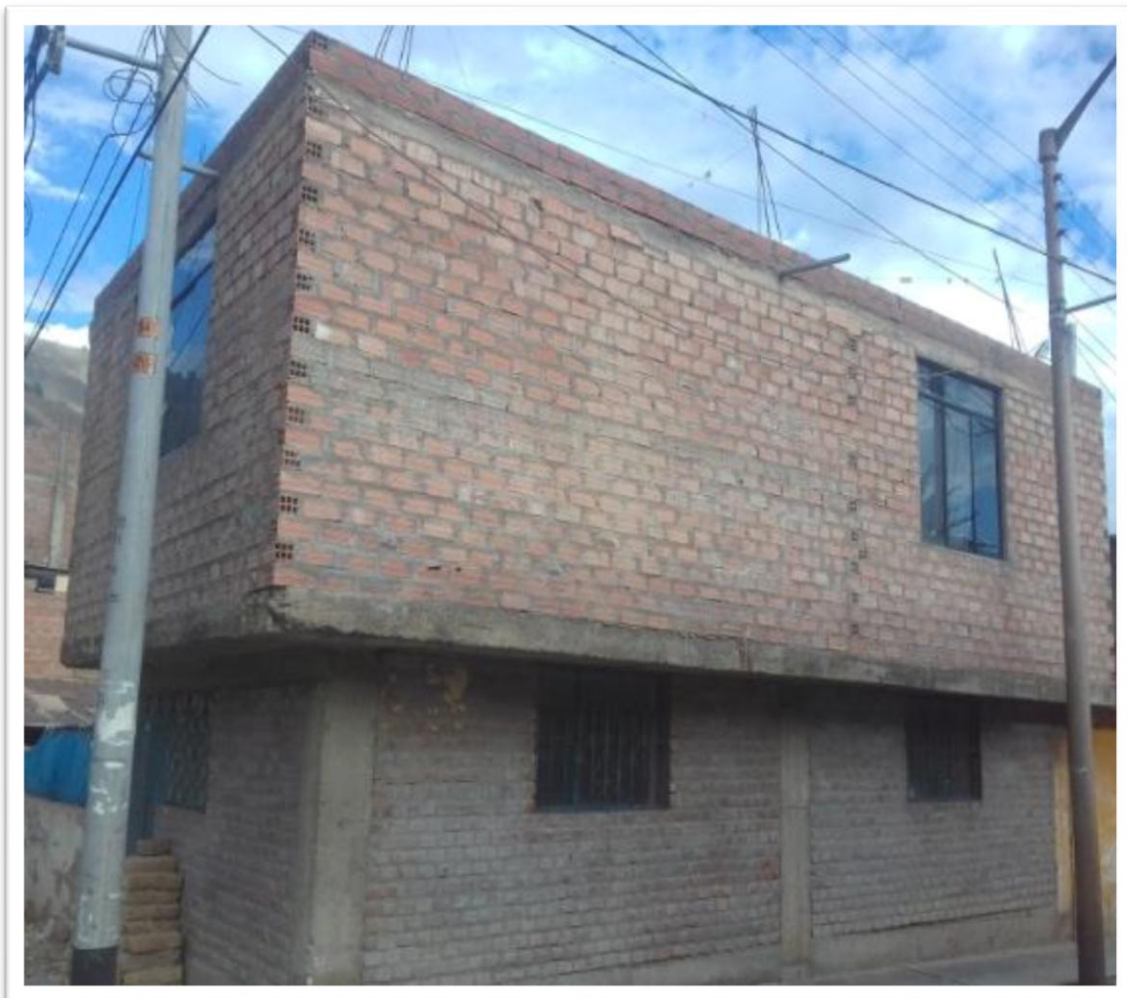
Distribución de las unidades de albañilería y mortero
