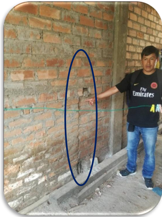
FOTOGRAFÍA 09. Se observa la baja calidad de los materiales de albañilería y el inadecuado asentado de los mismos en 2do nivel de la vivienda.
