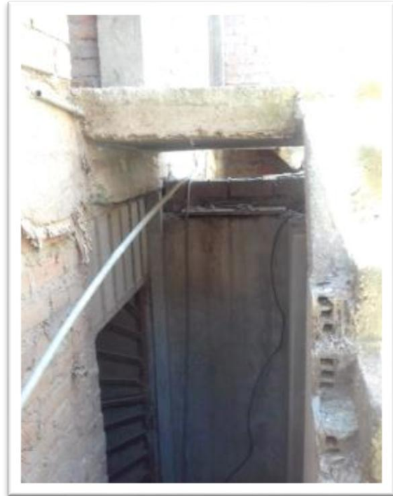
Reducción de la losa aligerada
