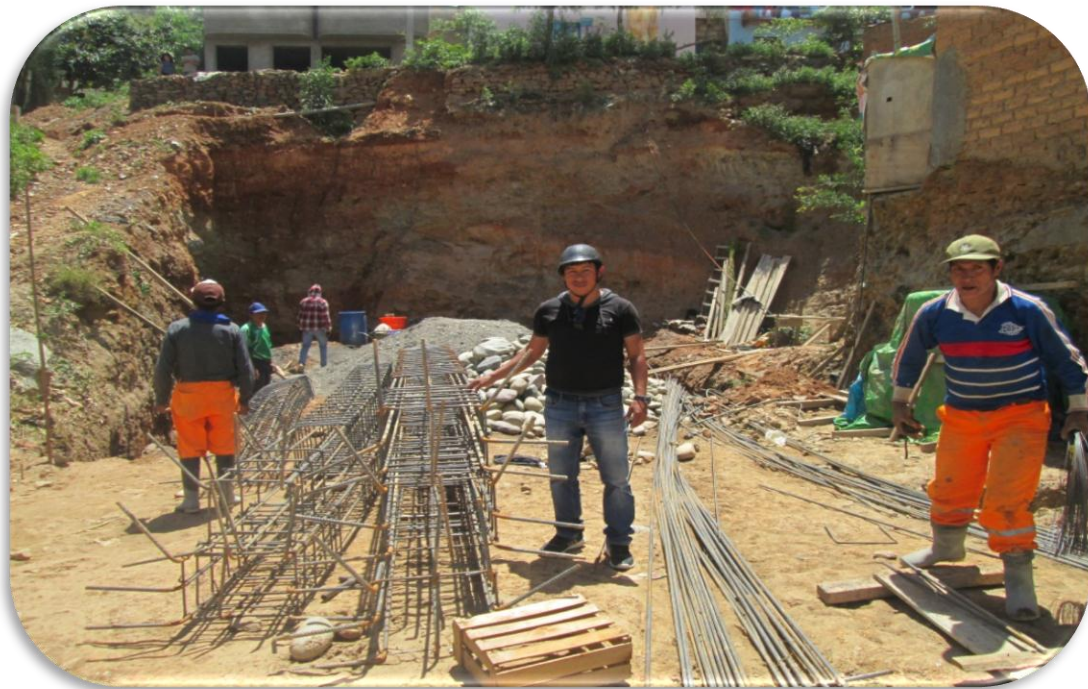
FOTOGRAFÍA 16. Visita a los proyectos de vivienda en proceso de construcción en el Asentamiento Humano Leoncio Prado.
