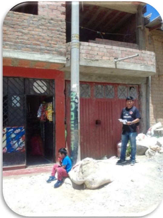
FOTOGRAFÍA 09. Se observa la baja calidad de los materiales de albañilería y el inadecuado asentado de los mismos en 2do nivel de la vivienda.
